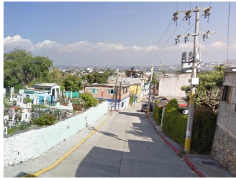
Se muestra la deficiencia de barda para delimitar el panteón.
