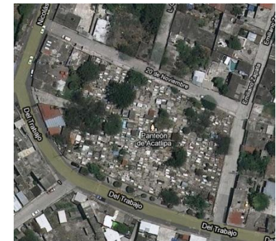
No existen pasillos para la circulación peatonal.
