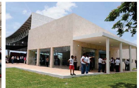
IMAGEN 24 .Edificio para deportes de piso
