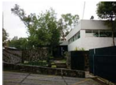
IMAGEN 71 Terreno, vista oriente.
