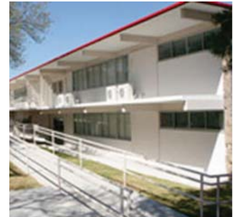
IMAGEN 27. Edificio de Dormitorios
