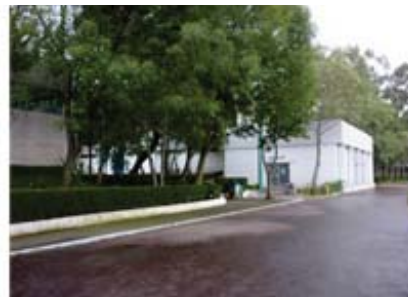
IMAGEN 72 Terreno, vista oriente.
