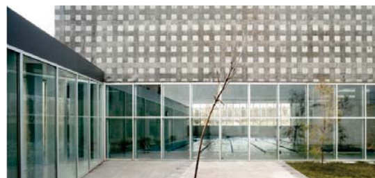
IMAGEN 31. Patio interior del conjunto
