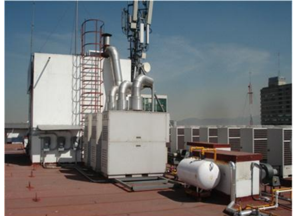
TIPO 1: AZOTEA EDIFICIO PRINCIPAL
