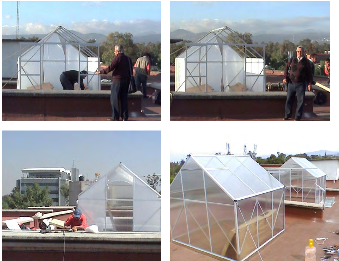
Fig. 5.2 Detalles de la construcción de las casetas de desalinización solar
