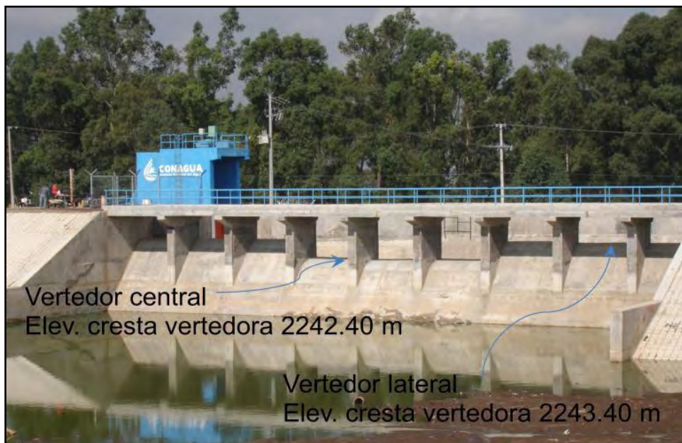
Fig 1.12.- Vertedor lateral de la derivadora San Francisco
