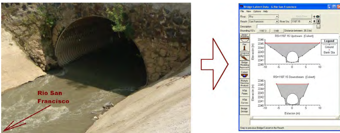
Fig 4.3.- Alcantarilla en cruce con autopista México-Puebla.
