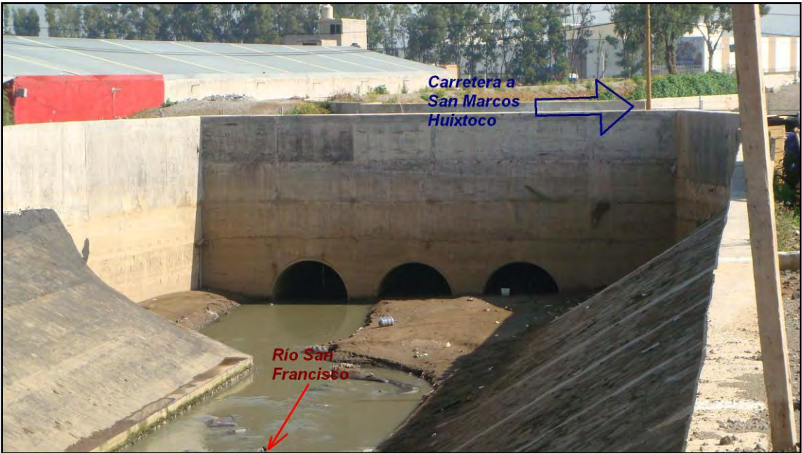
Fig 1.9.- Salida de las alcantarillas en el cruce con la carretera
