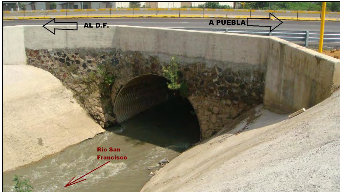
Fig 1.10.- Salida de la alcantarilla de cruce del río San Francisco y la Autopista
