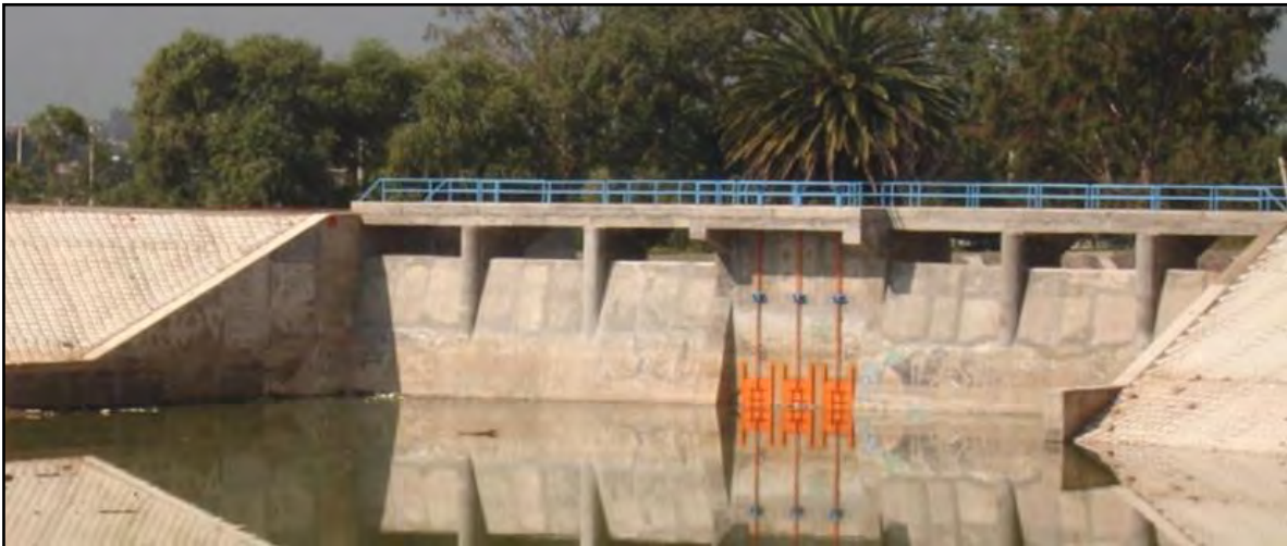
Fig 1.15.- Estructura de salida de la laguna La Gasera.
