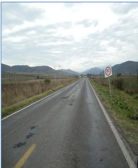
Foto del Km 102+500 en la cual se muestra el bacheo de tipo superficial como parte del mantenimiento preventivo.
