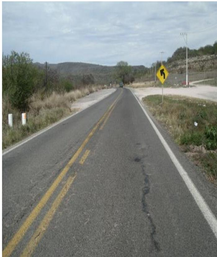
**VISTA HACIA ATRAS DEL KILÓMETRO 101+600 EN LA CUAL SE APRECIA LAS GRIETAS LONGITUDINALES Y EL DESGASTE DE AGREGADOS DE LA CARPETA ASÌ COMO LA VEGETACIÒN EXISTENTE EN LA ZONA**
