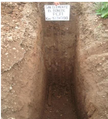
**VISTA DEL P.C.A. UBICADO EN EL KILÓMETRO 123+000, EN LA CUAL, SE OBSERVA EL TERRENO NATURAL ASI COMO EL TIPO DE MATERIAL, HUMEDO DE COLOR CAFE OSCURO DE BAJA A MEDIANA PLASTICIDAD EXISTENTE EN LA ZONA.**
