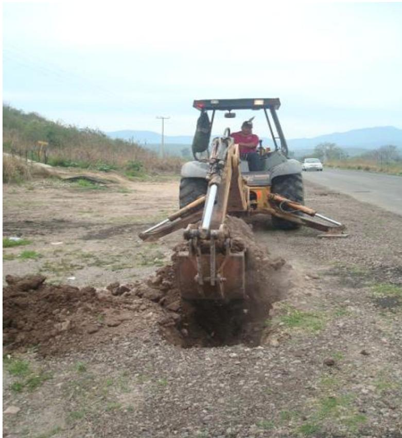
**Vista de la excavación con maquina del pozo a cielo abierto ubicado sobre el eje de trazo en el km 132+500 en la cual podemos observar material en estado suelto, de donde determinamos el peso volumétrico en estado suelto.**
