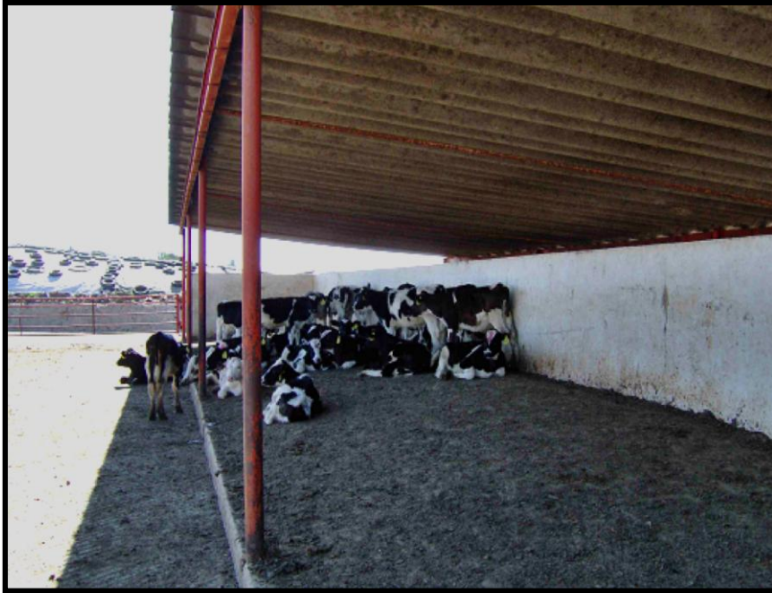
Figura 16. Fotografía que muestra las características de un establo donde los becerros están en corrales de 10 x 25 m., con suelo de tierra y concreto.
