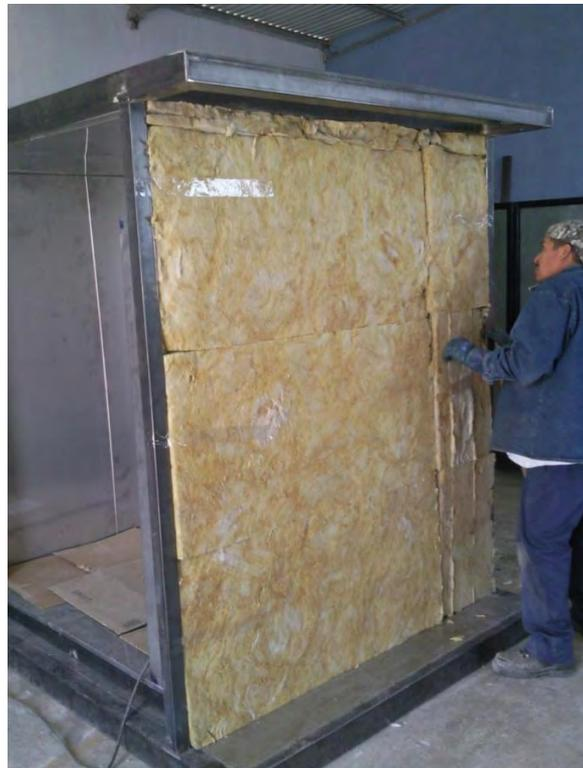
Se coloca el aislante lana mineral con un espesor 3" en la partes posteriores y laterales.
