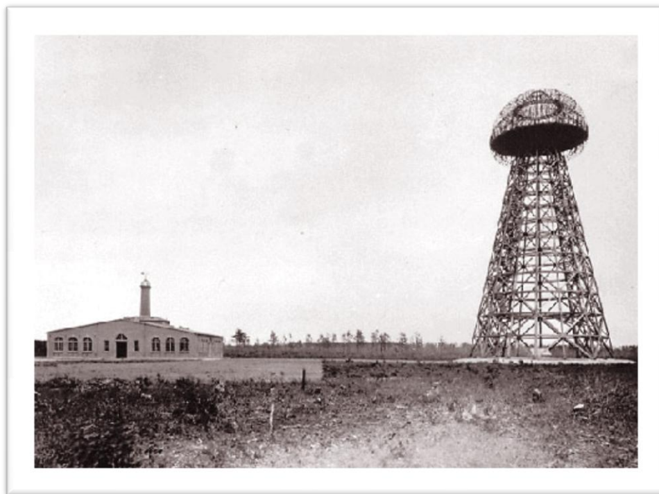
Figura 5.3 Torre de Wanderclyfe
