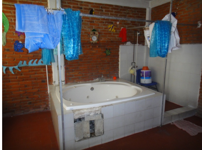
Figura 3a. Salón de hidroterapia. De izquierda a derecha está: el vestidor, la tina y la regadera.
