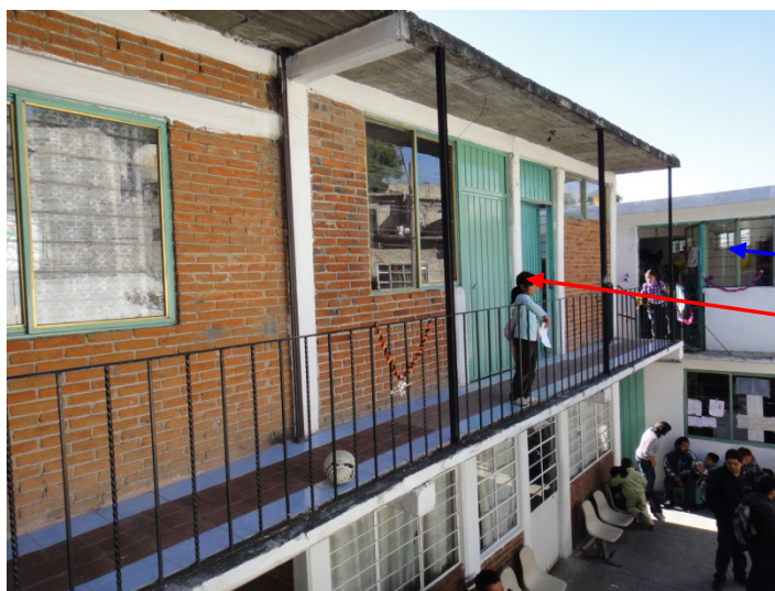
Figura 14a. Salón utilizado para la Terapia Psicológica (flecha roja). Salón en proceso de construcción (flecha azul)
