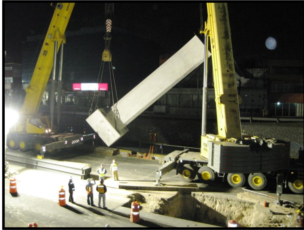
Imagen 37 LEVANTAMIENTO DE ZAPATA COLUMNA POR MEDIO DE GRÚAS
