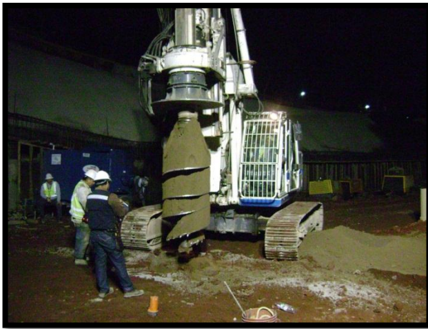
Imagen 21 EQUIPO DE PERFORACIÓN Y BROCAS
