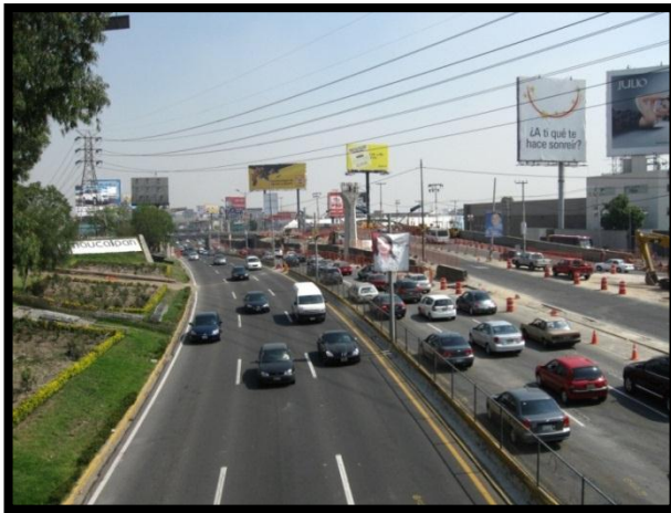
Imagen 5 INTERSECCIÓN DE CABLES EN VIALIDAD
