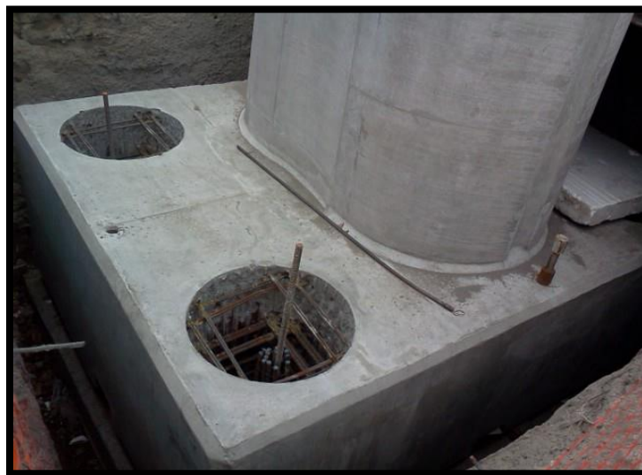
Imagen 34 UNIÓN ZAPATA Y PILA
