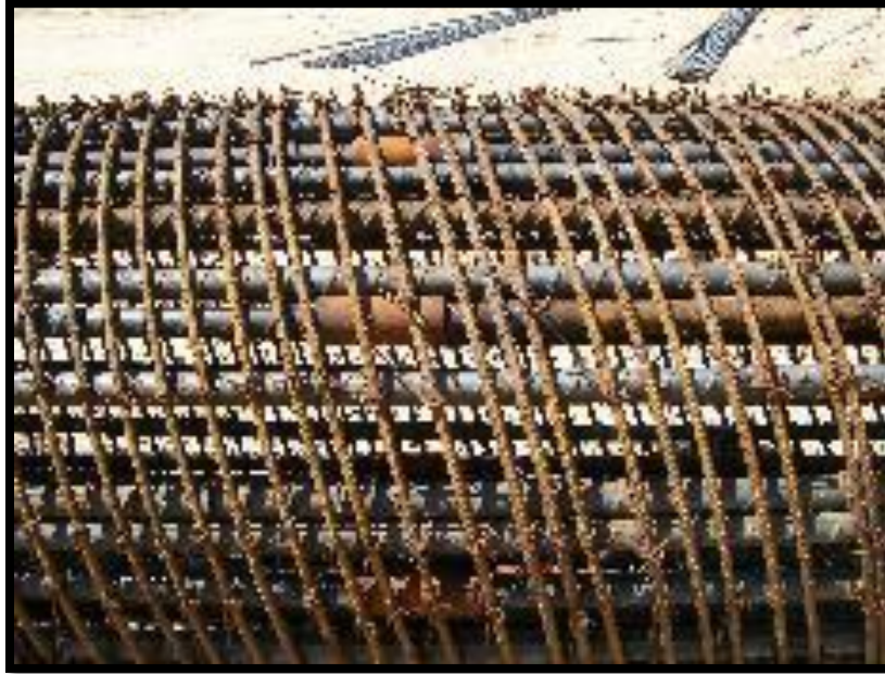
Imagen 22 ARMADO DE PILAS
