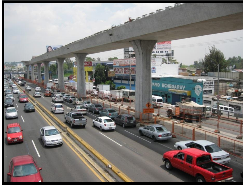
Imagen 17 ENMALLADO DE OBRA PARA TRABAJOS EN EL DÍA
