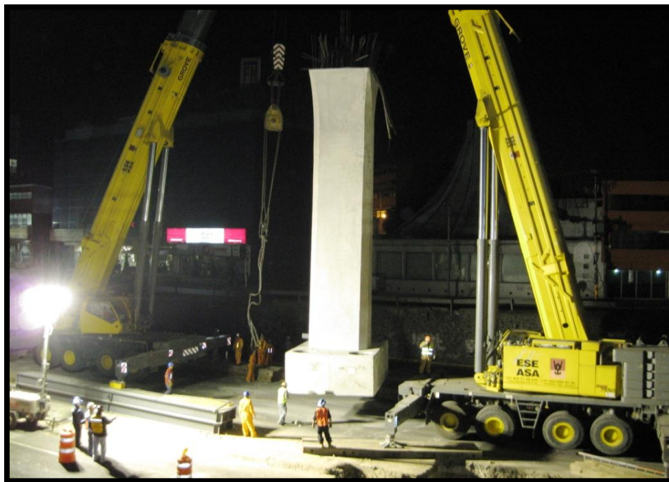
Imagen 37 LEVANTAMIENTO DE ZAPATA COLUMNA POR MEDIO DE GRÚAS
