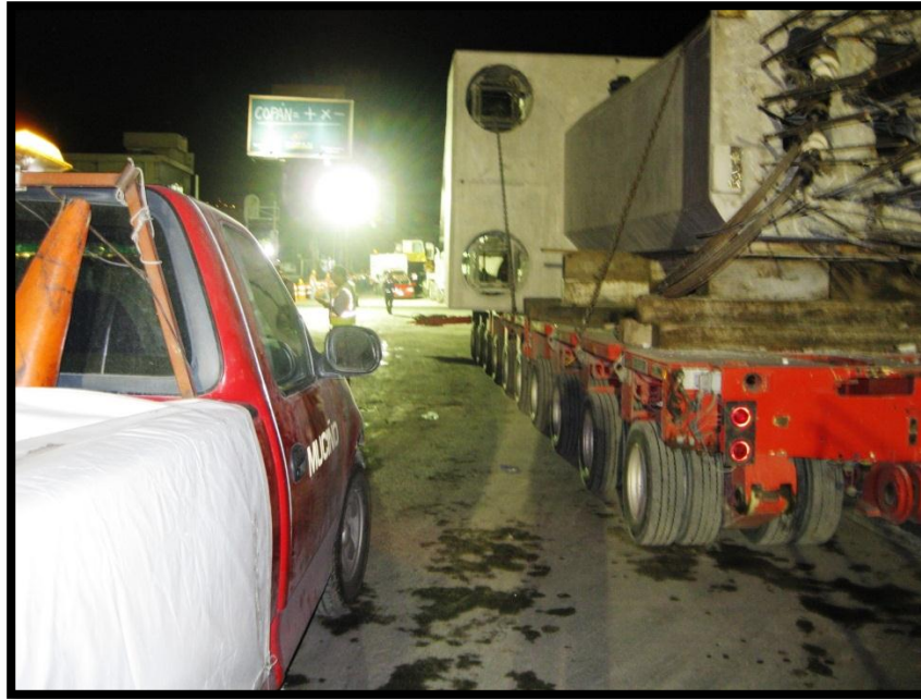
Imagen 35 LLEGADA DE ZAPATA COLUMNA A OBRA
