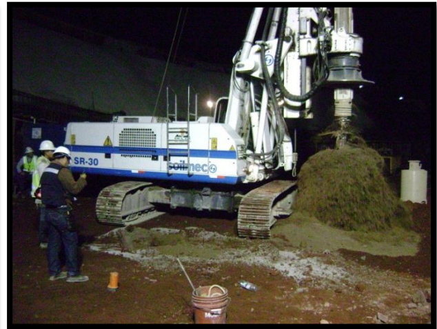
Imagen 20 PERFORACIÓN EN OBRA
