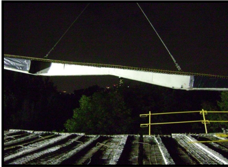
Imagen 57 MONTAJE DE TABLETAS
