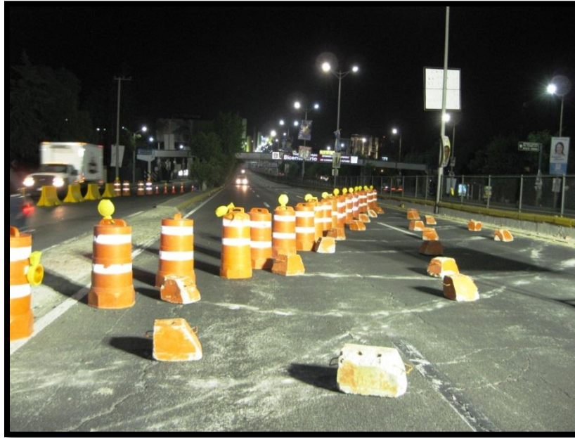
Imagen 16 CIERRES NOCTURNOS EN VÍAS PARA CONSTRUCCIÓN DE OBRAS
