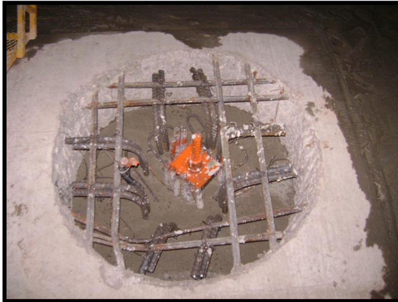
Imagen 25 PILAS CON TORNILLO CENTRADOR
