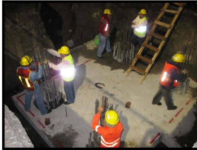
Imagen 19 CONSTRUCCIÓN DE ZAPATAS
