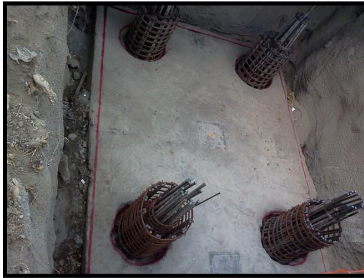
Imagen 28 VISTA DE PLANTILLA TERMINADA
