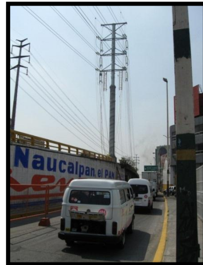
Imagen 6 LEVANTAMIENTO DE CABLES TERMINADO
