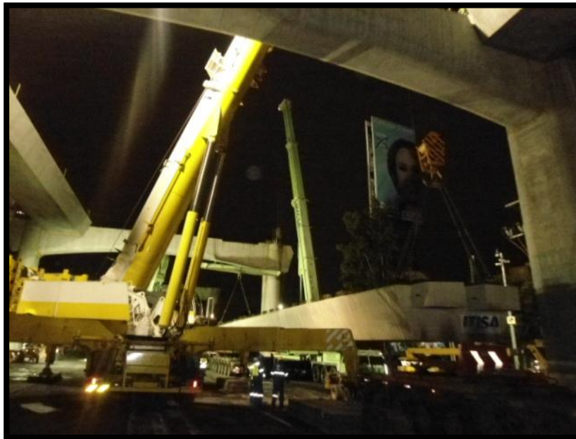
Imagen 47 INICIO DE MONTAJE DE TRABE
