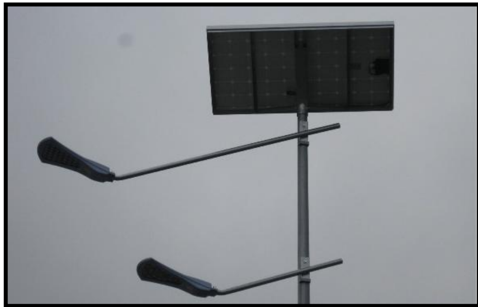
Imagen 15 ILUMINACIÓN POR MEDIO DE PÁNELES SOLARES Y LEDS
