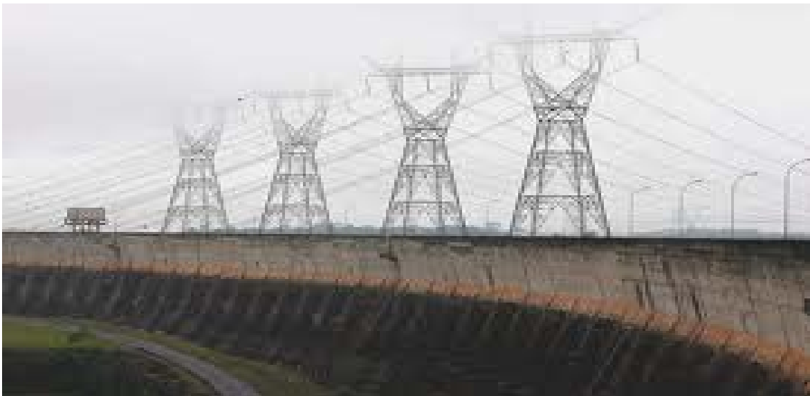
Figura IV.1 Líneas de transmisión
