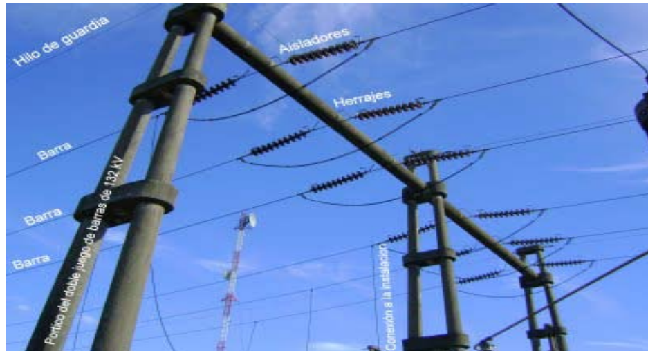
Figura IV.19 ubicación de barras colectoras
