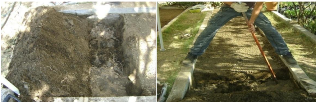
Figura 3. Excavación de la primera zanja de 30 x 30 cm.
