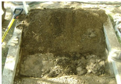
Figura 4. Excavación de la segunda zanja de 30 x 30 cm.
