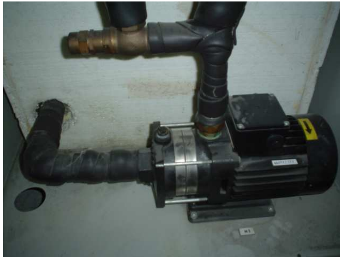
Figura 2.13 Tanque de refrigeración y bomba de agua encontradas en el módulo externo de la máquina CNC.
