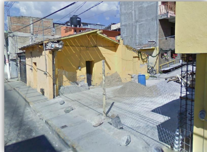
FOTO C12. Demolición de casa habitación, Colonia Centro.
