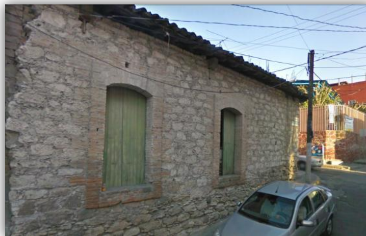
FOTO C04. Colonia Centro, derribada en 2013.
