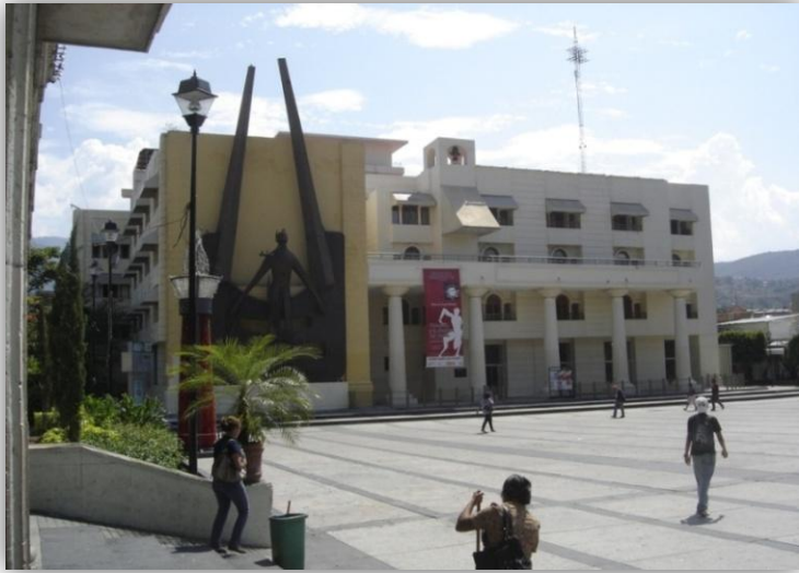
FOTO B05. Antiguo Palacio de Gobierno (actual Palacio de la Cultura), después de demoler los dos últimos niveles, 2005. 7
