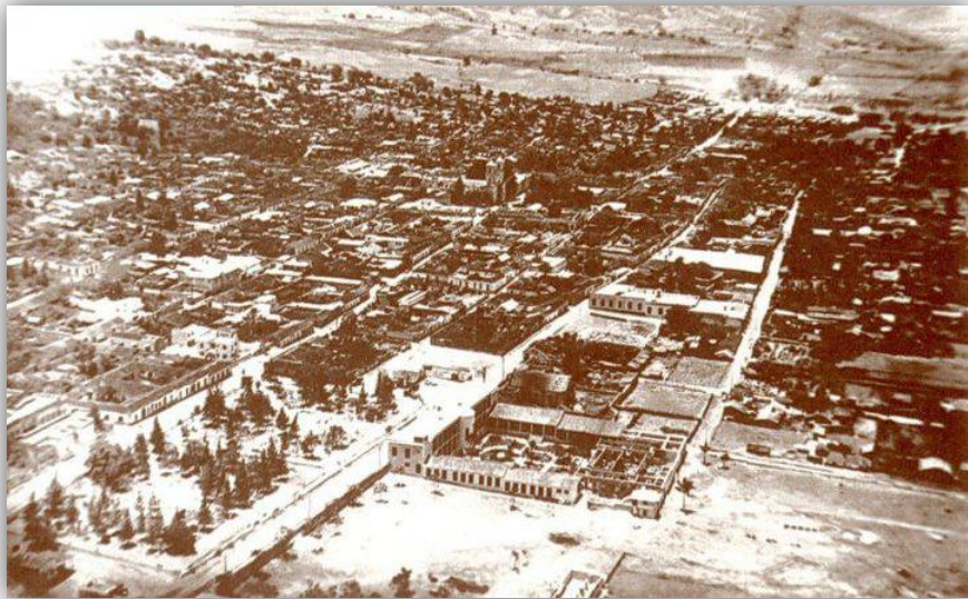
FOTO A09. Vista panorámica norte-sur, 1940 aprox. 1
