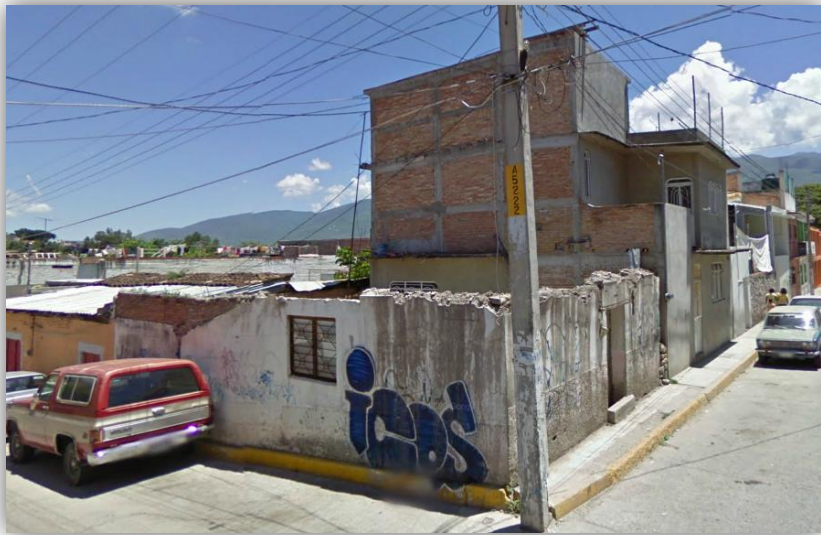
FOTO C06. Demolición de casa habitación, Barrio San Mateo.
