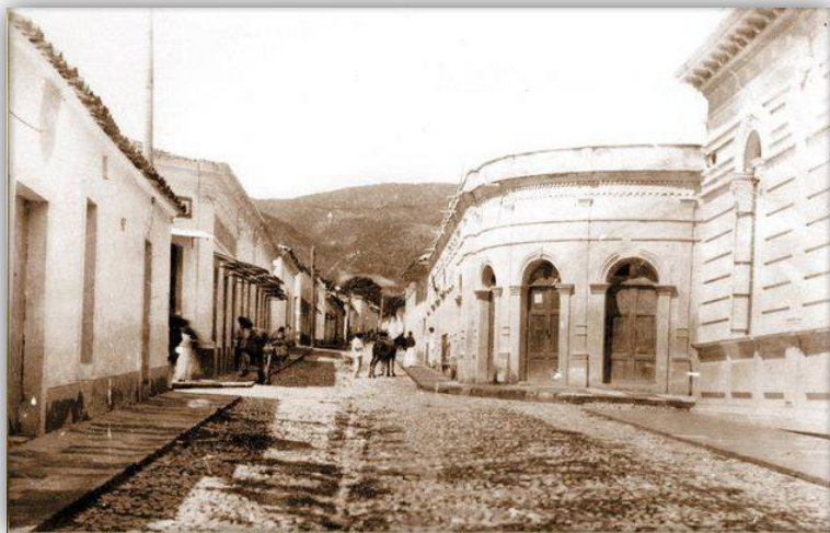
FOTO A01. Calle 16 de septiembre, 1911. 1
