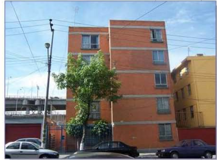
1.- Francisco Espejel No. 10 20 viviendas
