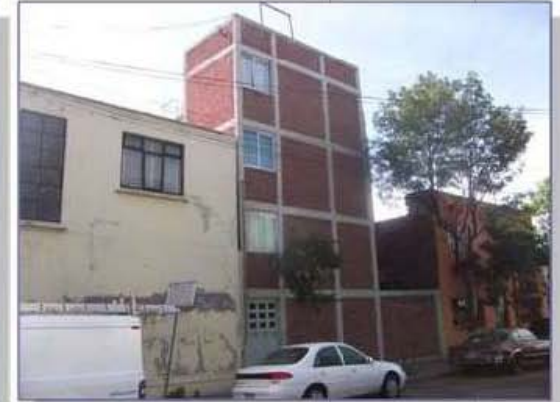
2.-Luis Preciado de la Torre No. 55 8 viviendas
