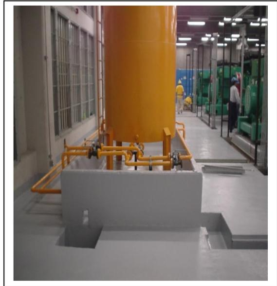
Cuando los derrames químicos o de solventes son ocasionales y es norma la limpieza inmediata, se puede considerar, que casi todos los recubrimientos epóxicos 100% sólidos, tienen la capacidad de tolerar sus acciones aún con los productos de uso general.
