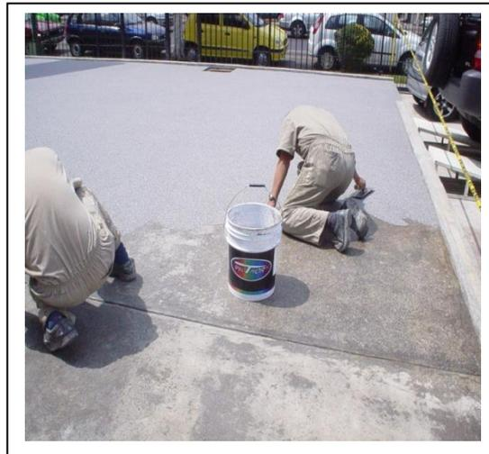
La aplicación de mortero epóxico incrementará la resistencia a la compresión y al desgaste <sup>(27)</sup>. Es también muy importante investigar el tipo de rodaja que utilizaran los equipos, por ejemplo los diámetros de las ruedas, el tipo de material que friccionará el piso, el área de contacto, el dibujo, la flexibilidad de la rueda, el material de fabricación, polímero sólido, neumática o de metal, etc.
