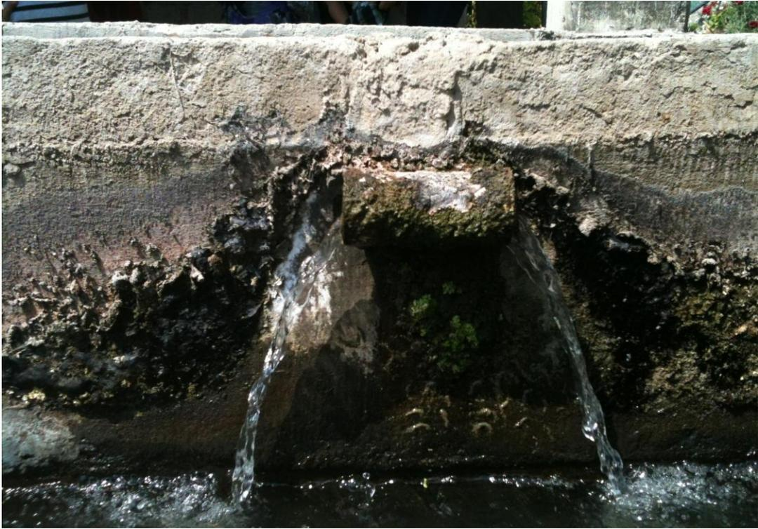
Figura 16. Caída del agua del sedimentador hacia el primer par de filtros.
