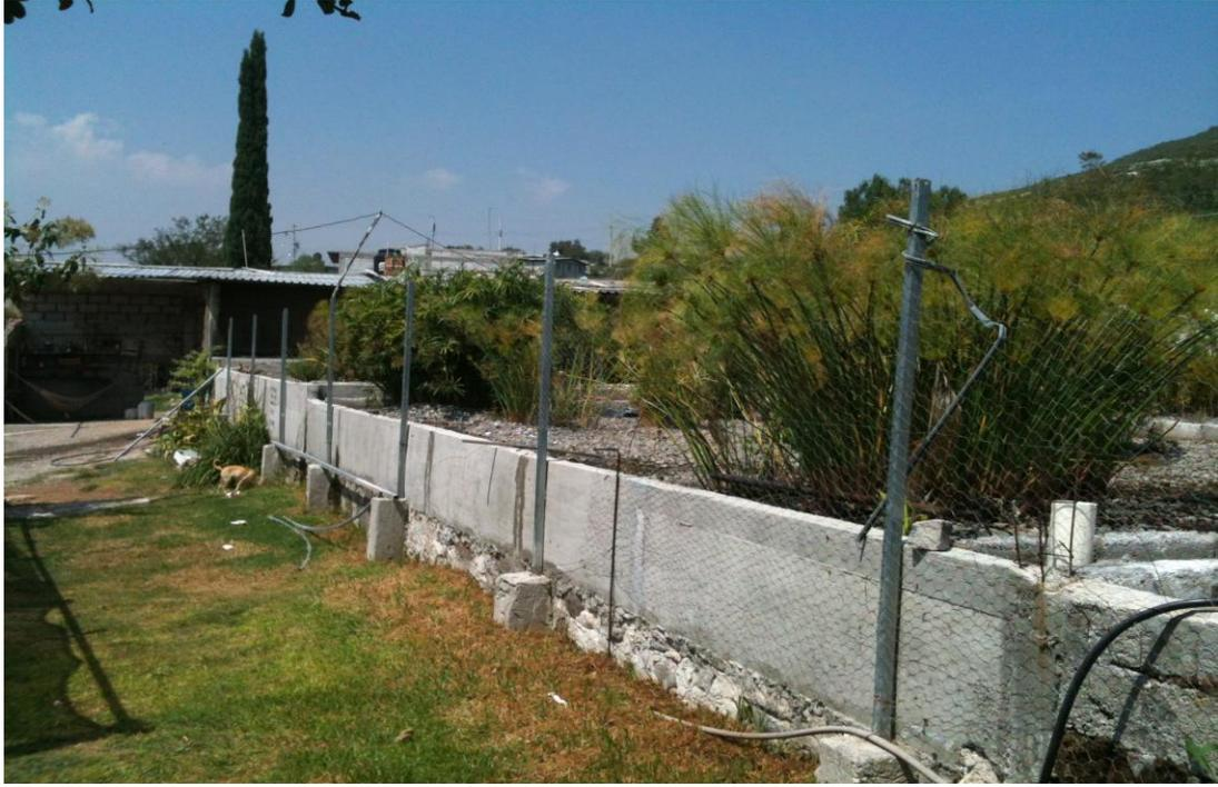
Figura 22. Vista lateral del sistema, donde se aprecian los desniveles del humedal que permiten la caída del agua, recorriendo así cada uno de los filtros.
