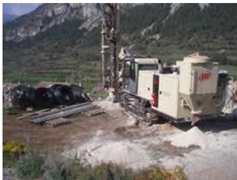
Fig. 2.6 Perforación de un pozo Geotérmico
