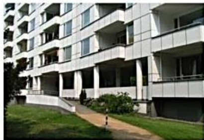
Vista de rampa de acceso y balcones
