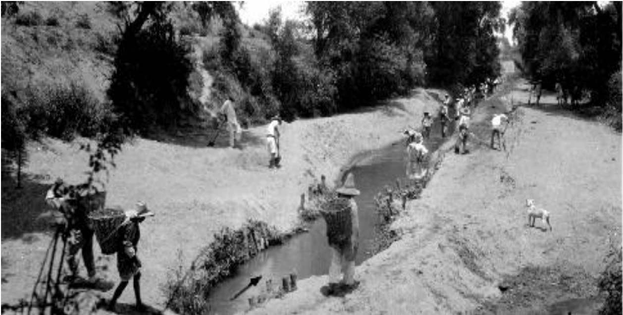
Construyendo el canal, fotografía obtenida del Archivo de Aguas Nacionales.
