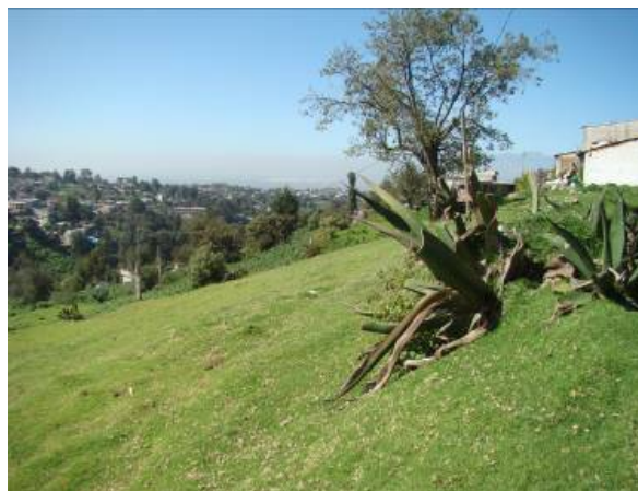
Figura 34. Ladera con rasgos de deslizamiento.
