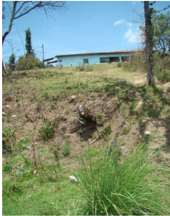
Figura 37. Ladera de barranco se distinguen escalonamientos.
