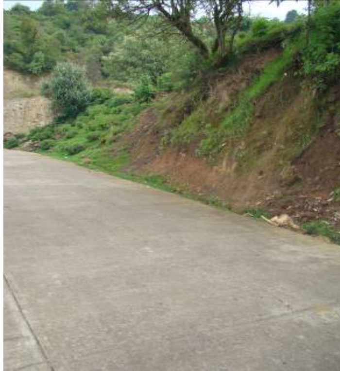
Figura 21. Corte de camino, se nota inclinación de los árboles en una ladera constituida por flujos piroclásticos y toba.
