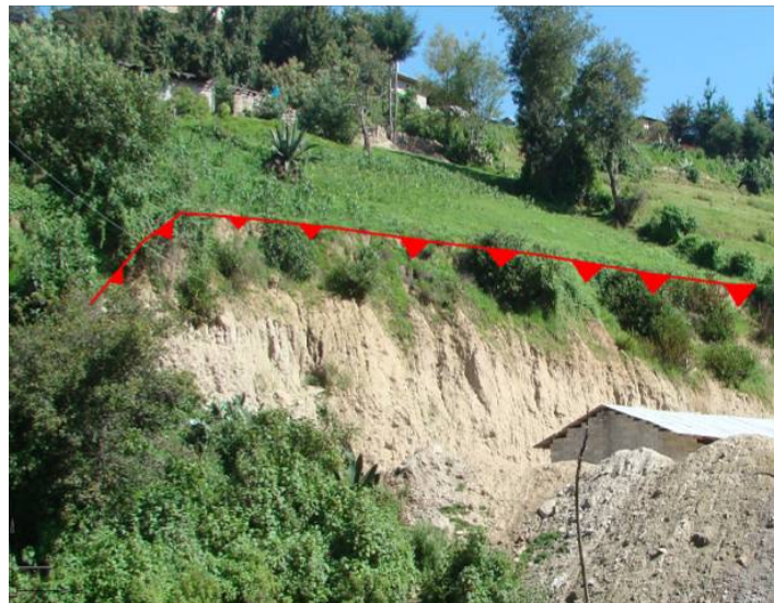
Figura 24. Ladera usada para la construcción de una cancha de futbol y al mismo tiempo para la construcción de una escuela primaria. Esta ladera muestra rasgos de procesos de deslizamiento como la inclinación de los árboles.
