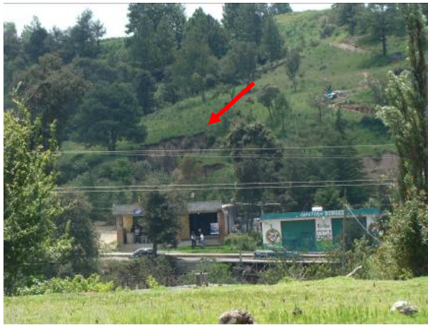
Figura 35. Ladera afectada por erosión, lo que está favoreciendo el proceso de deslizamiento.
