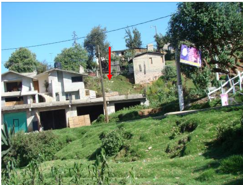
Figura 29. Ladera de fuerte pendiente con presencia de deslizamiento.
