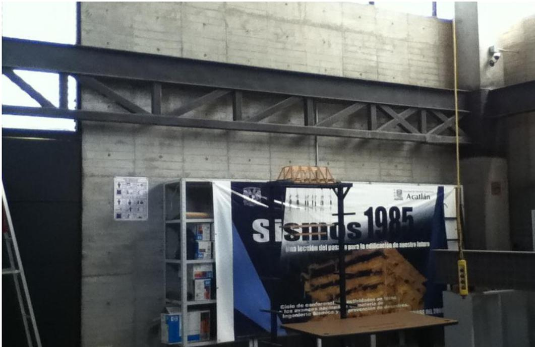
*Figura 1.5 Viga compuesta de UIM edificio "A"*
