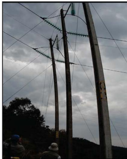
Figura 3.44 Postes deformados como evidencia de la continua actividad de deslizamiento.
