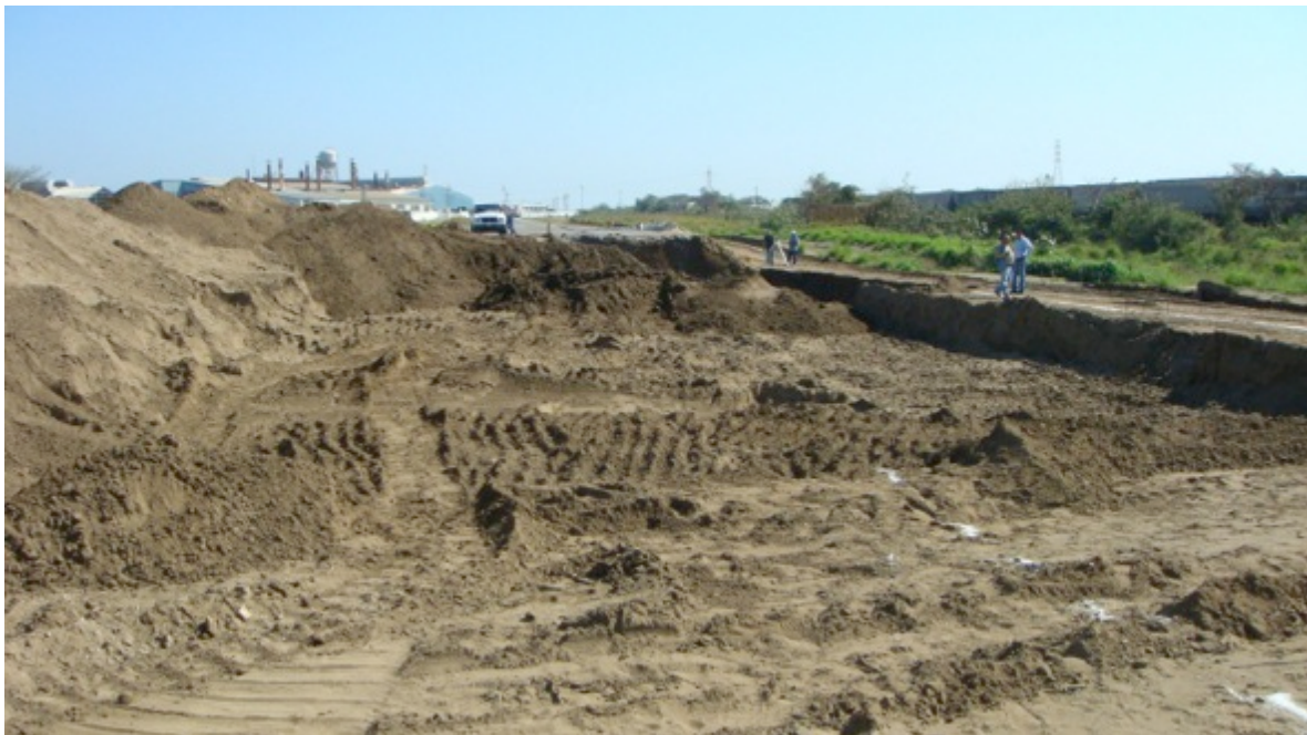
Fotografía A.4.2 Preparación del terreno, abriendo una caja en el terreno para el mejoramiento de la base.
