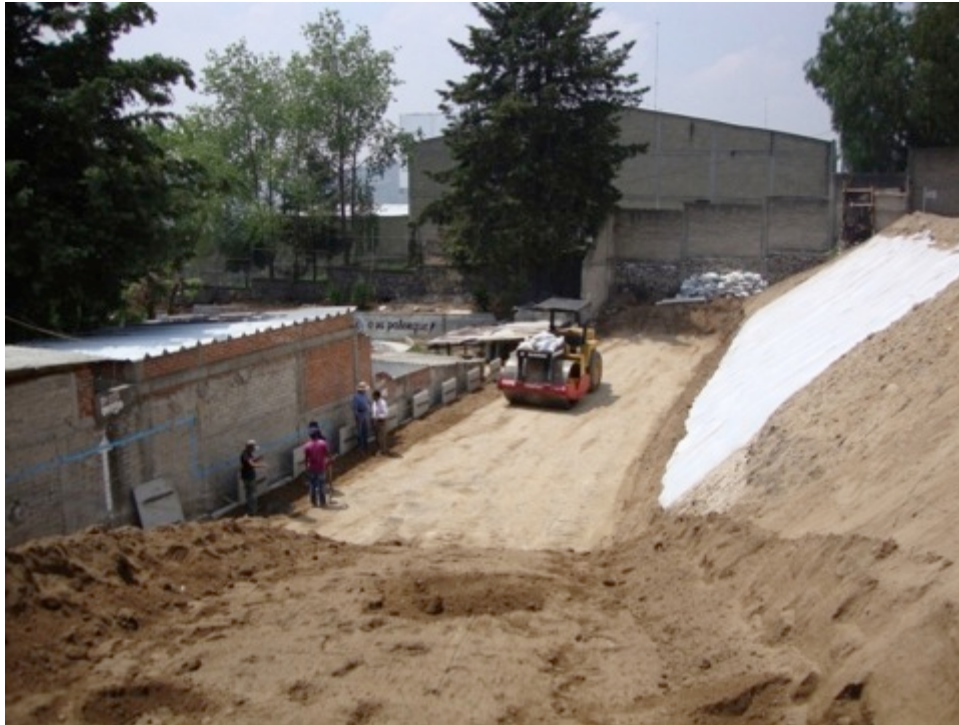
Fotografía 3.5 Proceso de compactación de un muro MSEW.
