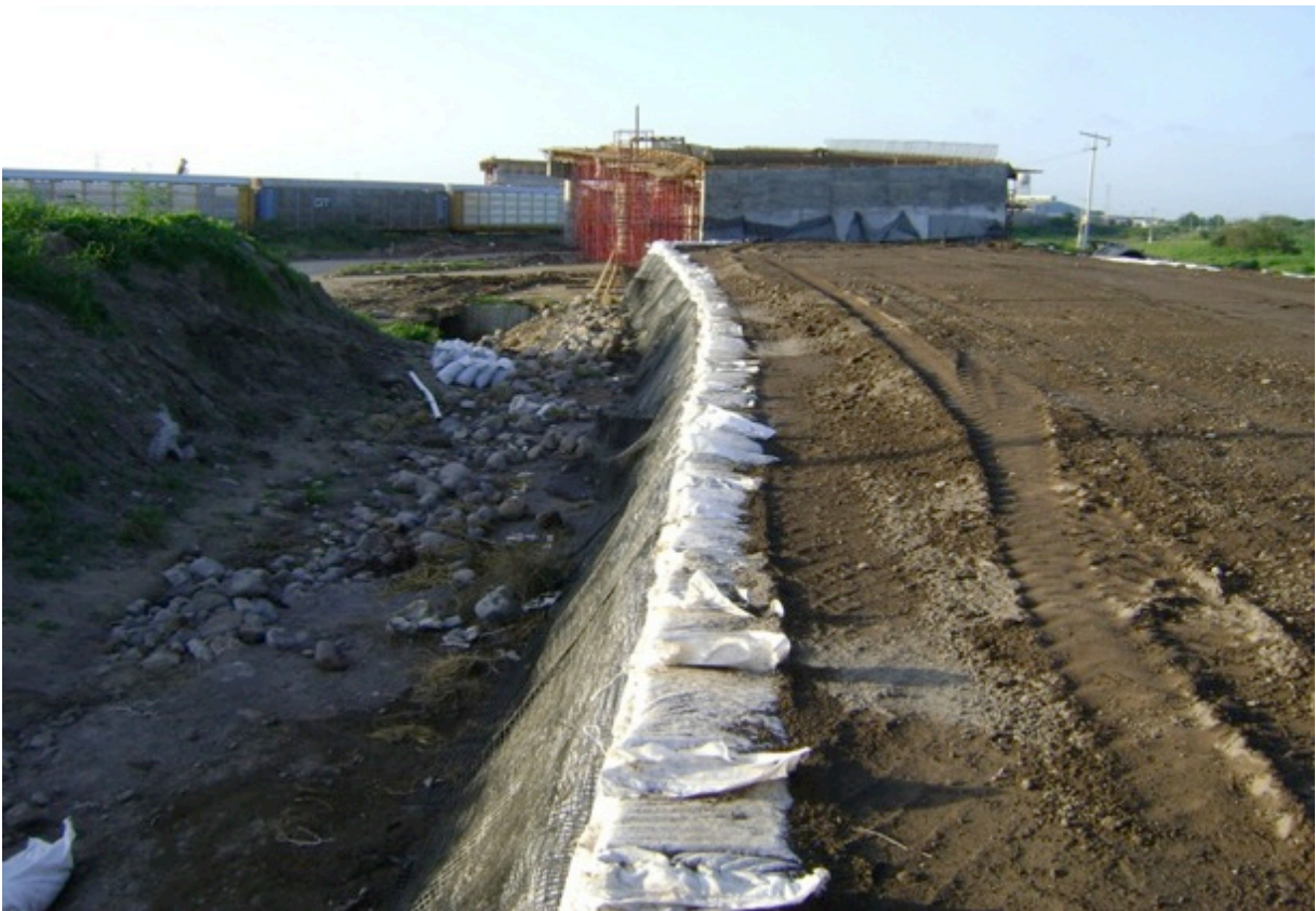
Fotografía A.4.4 Cimbra del terraplén a base de costales del mismo material de relleno.
