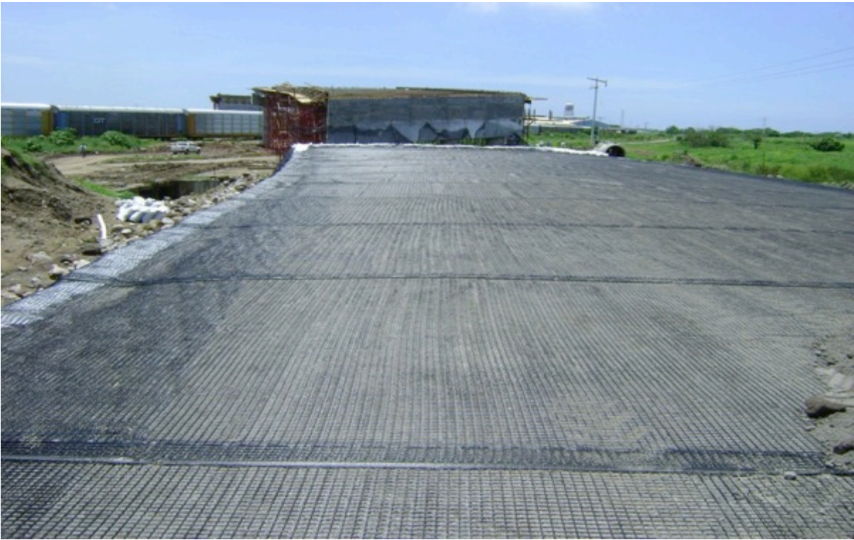
Fotografía A.4.5 Colocación de la geomalla en el terraplén.
