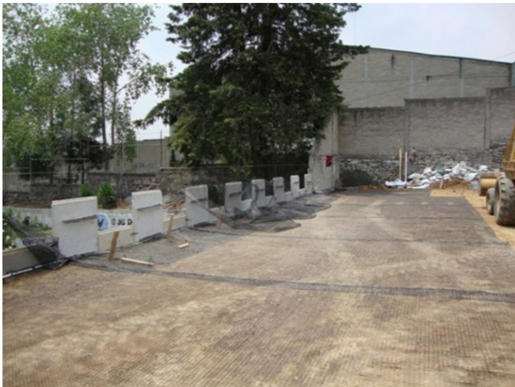
Fotografía 2.1 Muro de tierra mecánicamente estabilizado.
