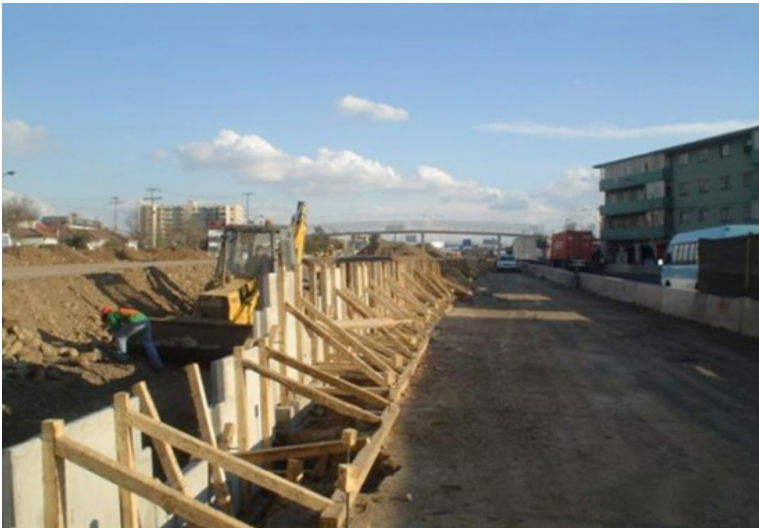
Fotografía 3.4 Montaje de la primera fila de escamas.
