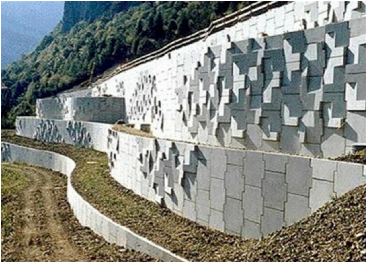
Fotografía 3.1 Muro de Tierra Armada.
