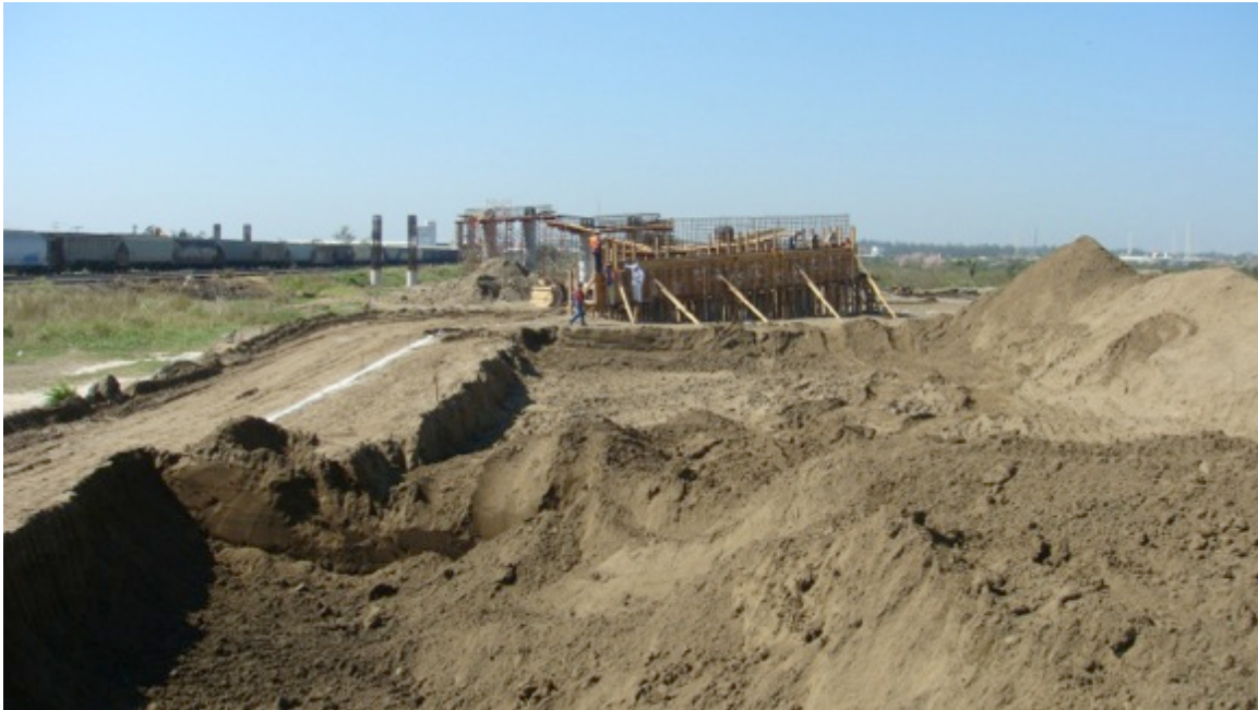
Fotografía A.4.1 Trabajos preliminares para las rampas de acceso al puente vehicular “La Nueva Veracruz”.
