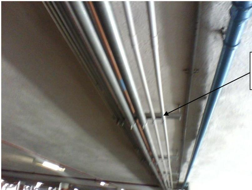
Toda la tubería debe estar firmemente sujeta a techos.
