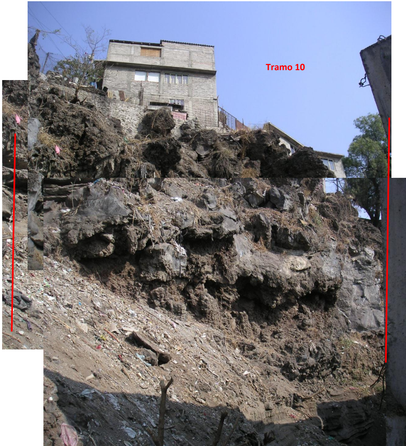
Figura 42. Vista frontal del tramo 10.
