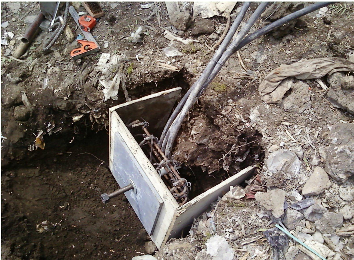
Figura 98. Armado de zapata.
