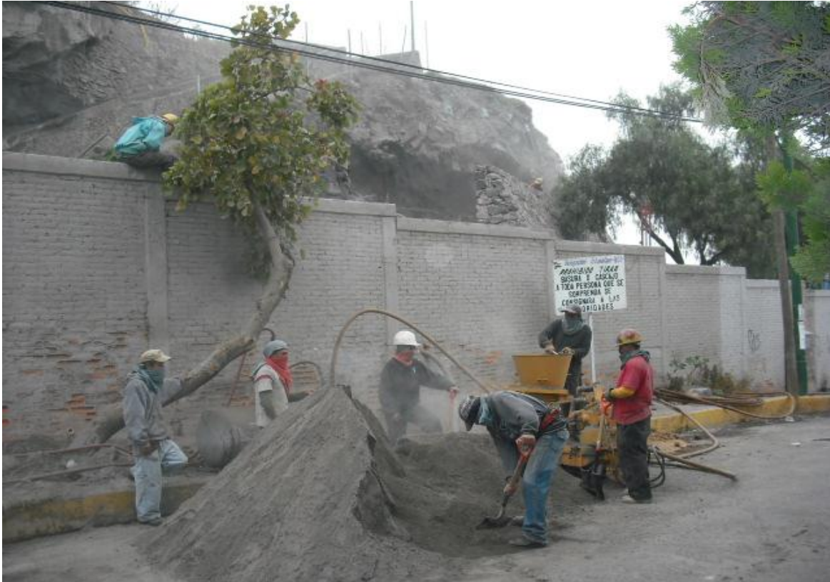
Figura 107. Preparación de mortero.
