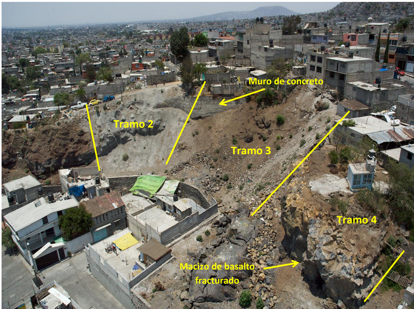
Figura 10. Vistas frontales del tramo 2, 3 y 4.
