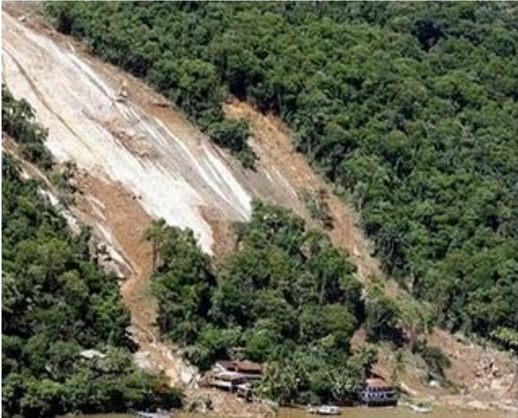
Figura 3. Flujo de material de una ladera.
