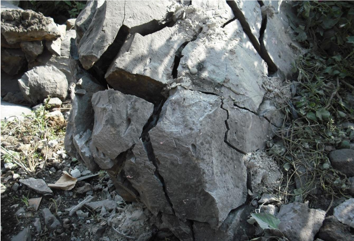
Figura 102. Demolición de roca volcánica mediante uso de expansores químicos.
