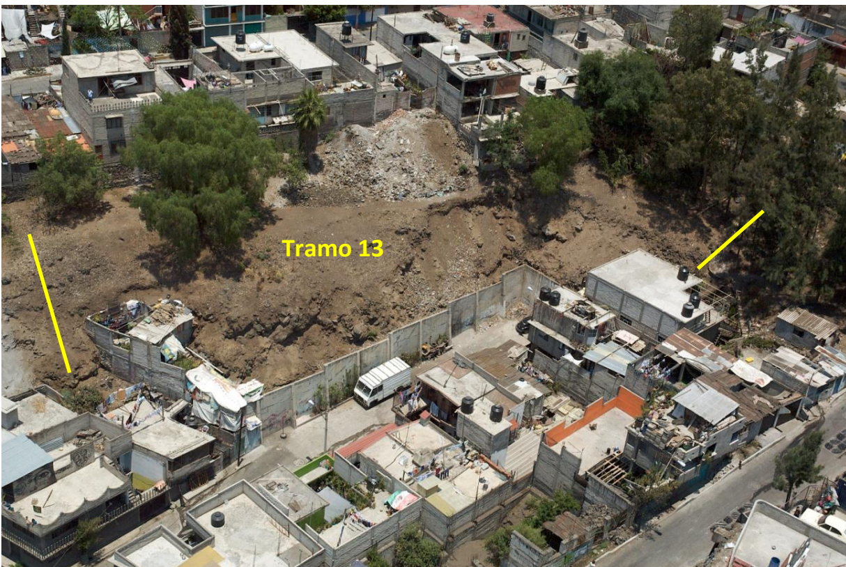
Figura 16. Vista frontal del tramo 13.
