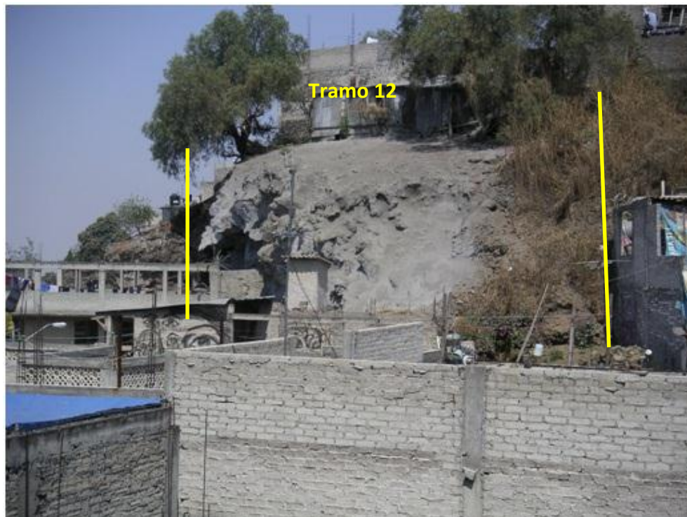
Figura 46. Vista frontal del tramo 12.
