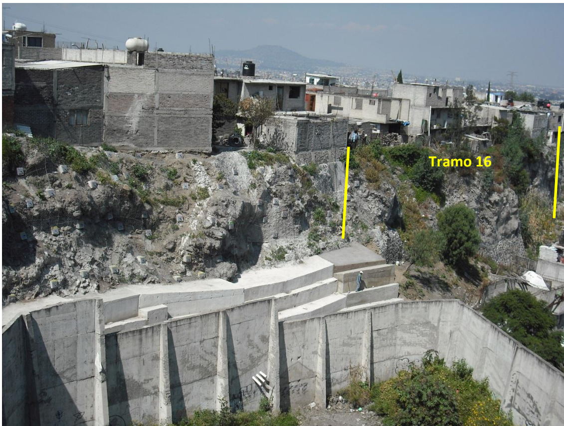
Figura 29. Vista frontal del tramo 16.
