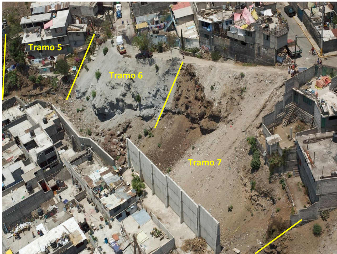
Figura 13. Vistas frontales del tramo 5, 6 y 7.
