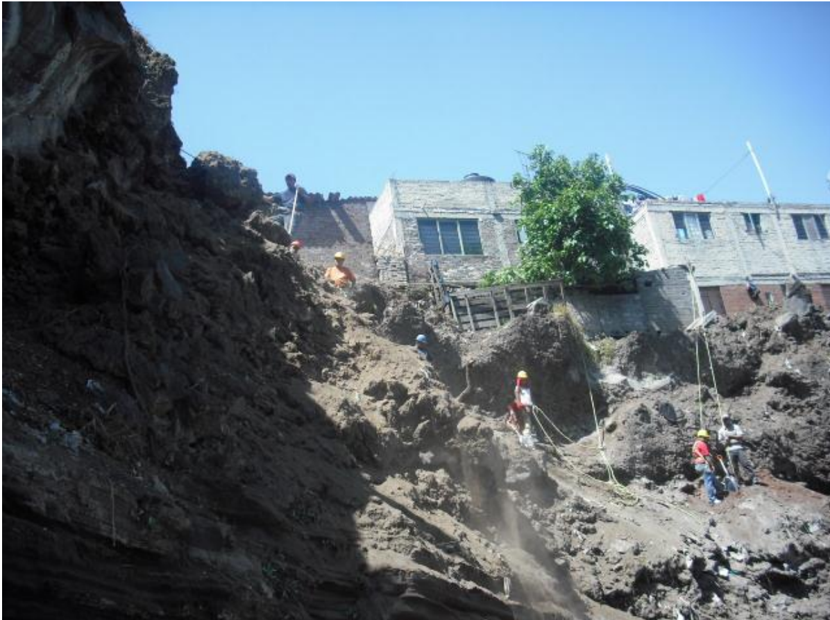
Figura 69. Limpieza manual de talud.
