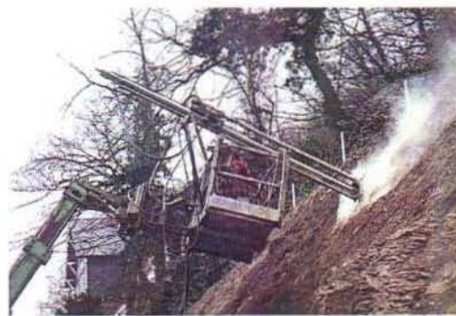
Ejemplo: Dependiendo de las condiciones del terreno, la perforación se ejecuta desde una plataforma soportada por una pequeña grúa o una plataforma colgada
