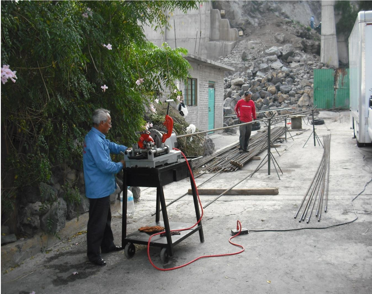
Figura 79. Habilidad en obra de cuerdas para anclas de varilla corrugada.
