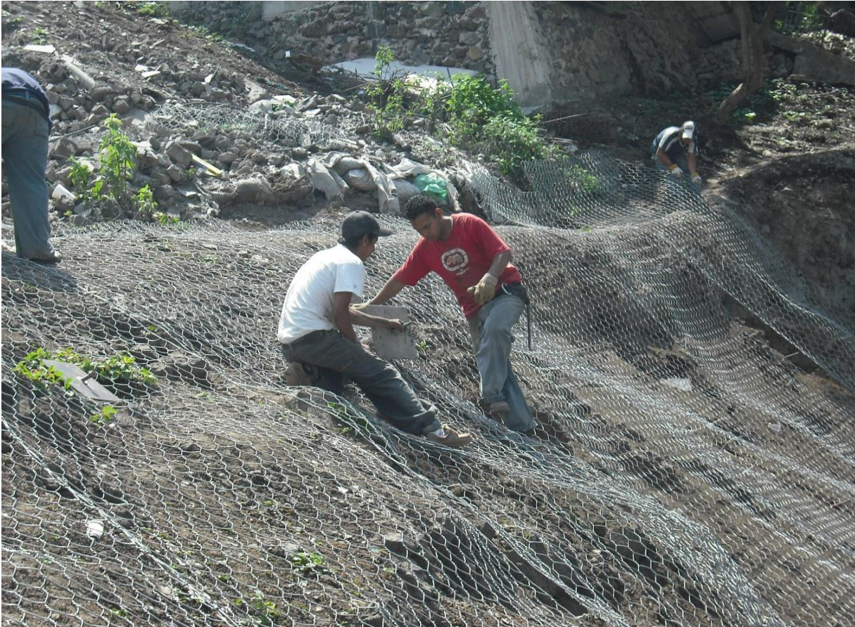
Figura 92. Colocación de malla triple torsión cubierta de PVC.
