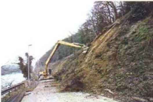
Medidas de preparación del talud (limpieza, desbroce, cortes parciales, etc.)
