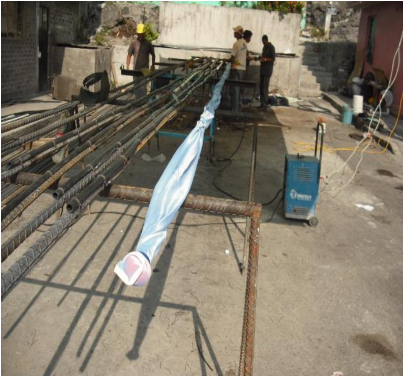
Figura 82. Soldado, preparación de anclas y colocación de tergalina, para tener menor pérdida de inyección lechada agua-cemento.
