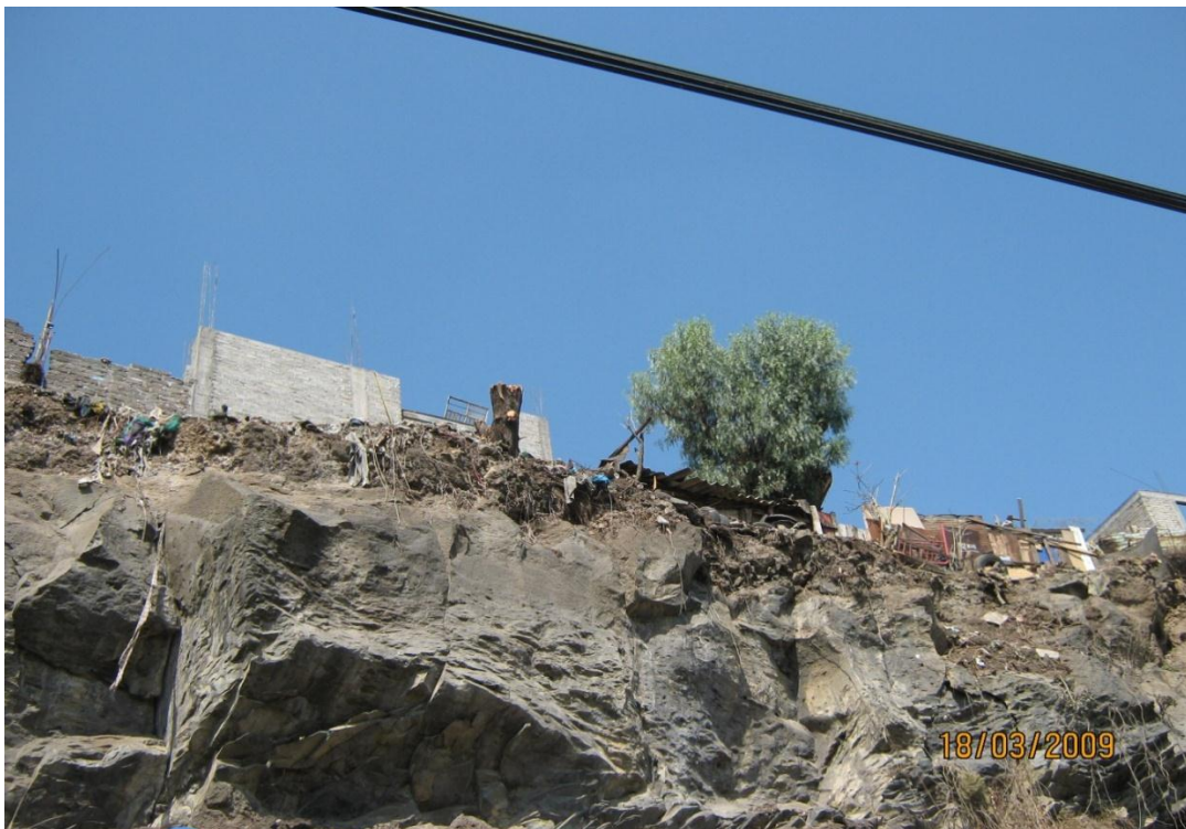
Figura 71. Retiro de árbol en zona inestable.
