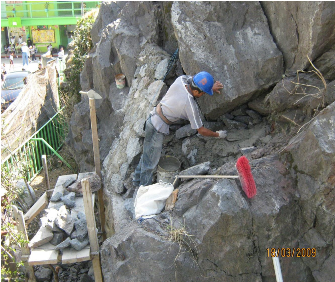
Figura 106. Relleno con mampostería en huecos.
