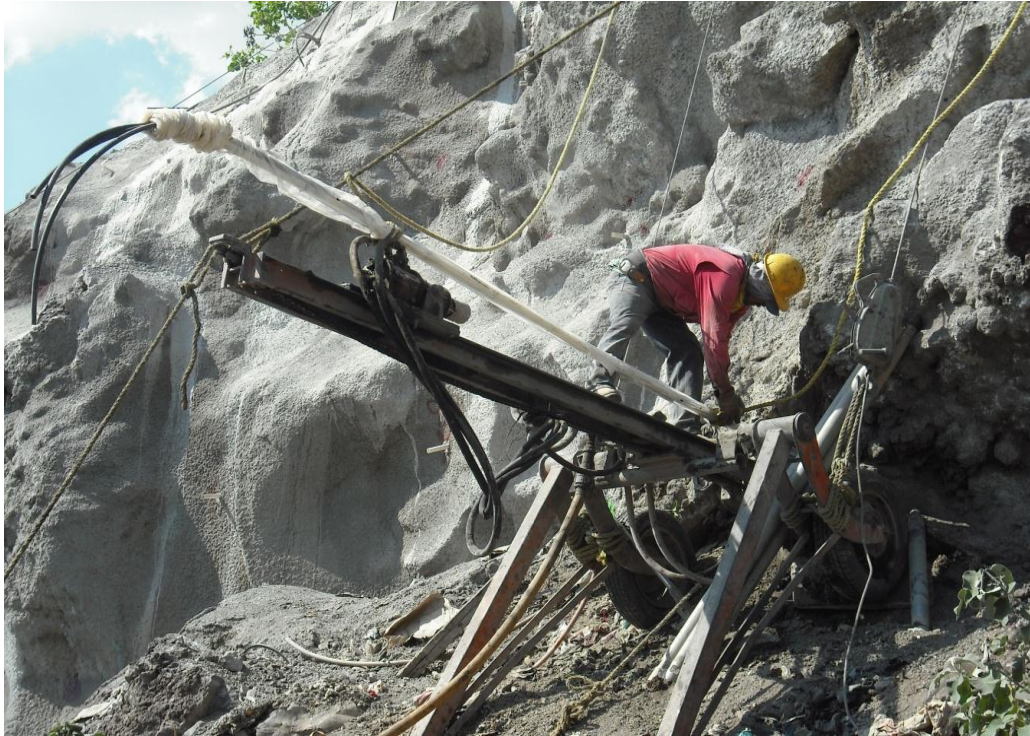
Figura 83. Colocación de anclas en concreto lanzado.
