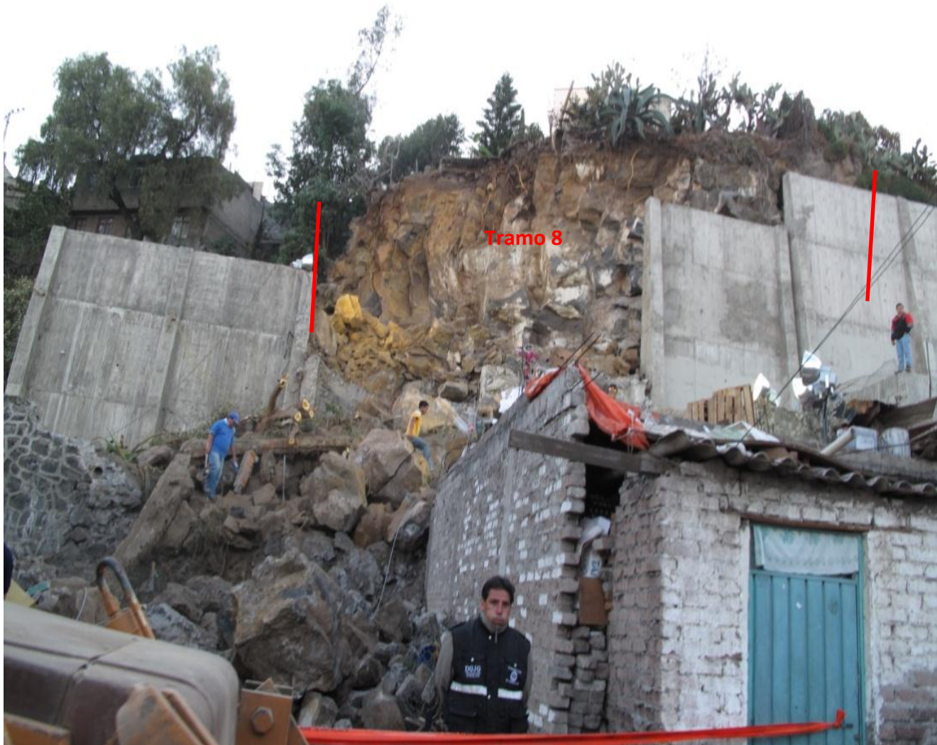
Figura 37. Vista frontal del tramo 8.
