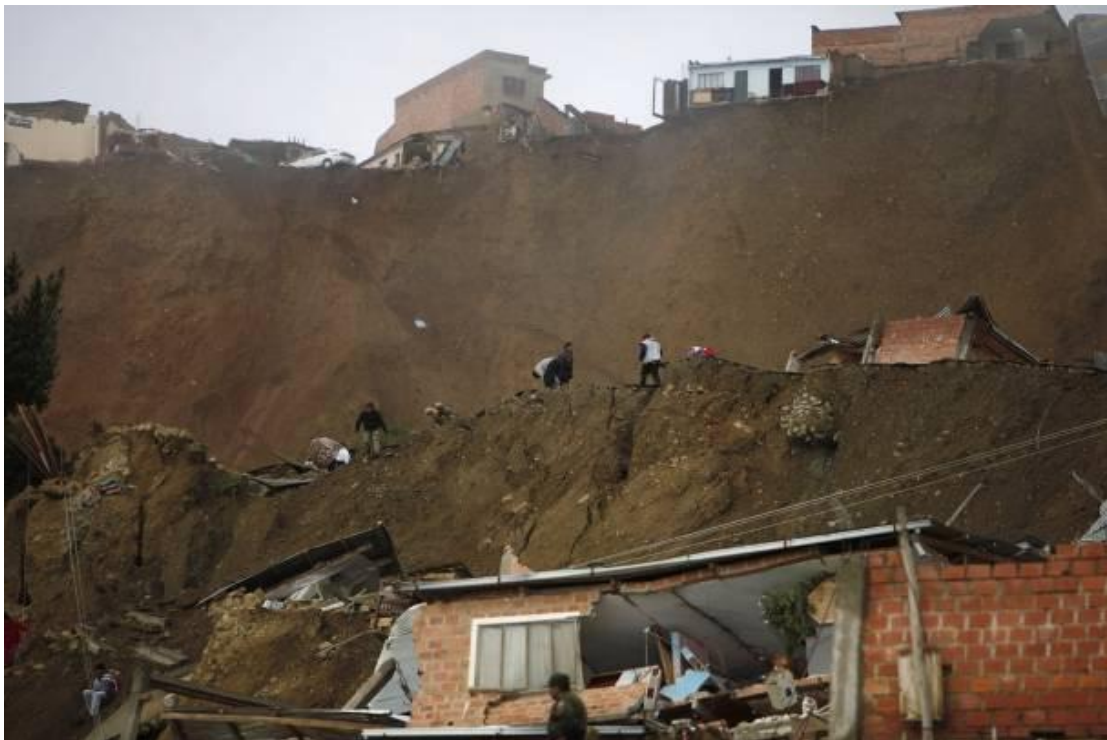
Figura 2. Ejemplo de un derrumbe o caído.
