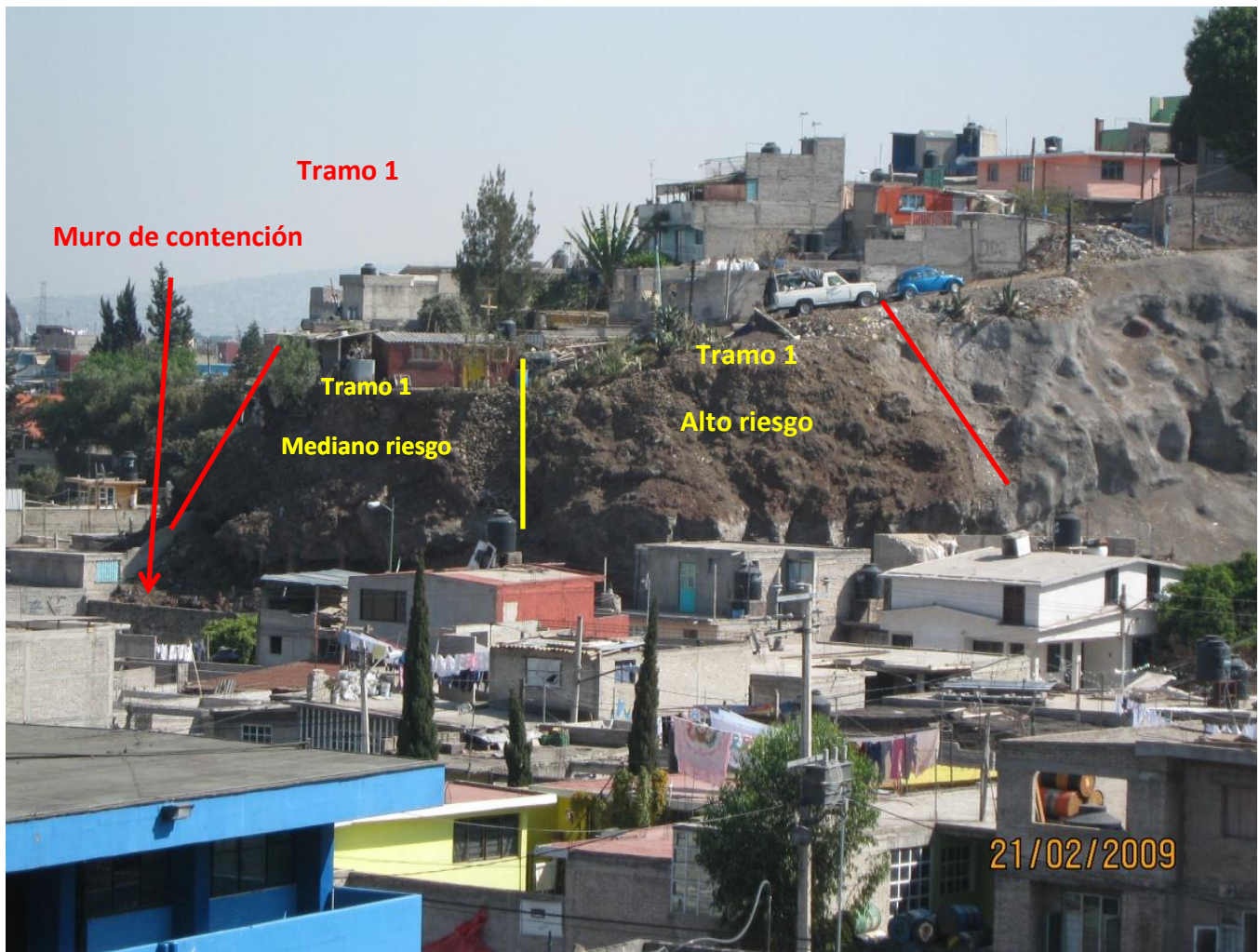
Figura 21. Vista frontal del tramo 1.
