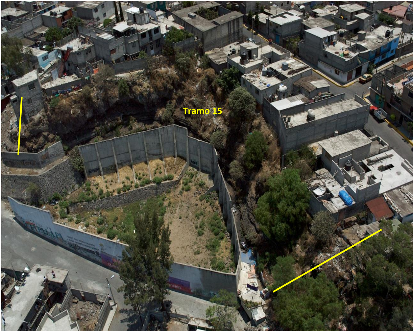
Figura 27. Vista frontal del tramo 15.
