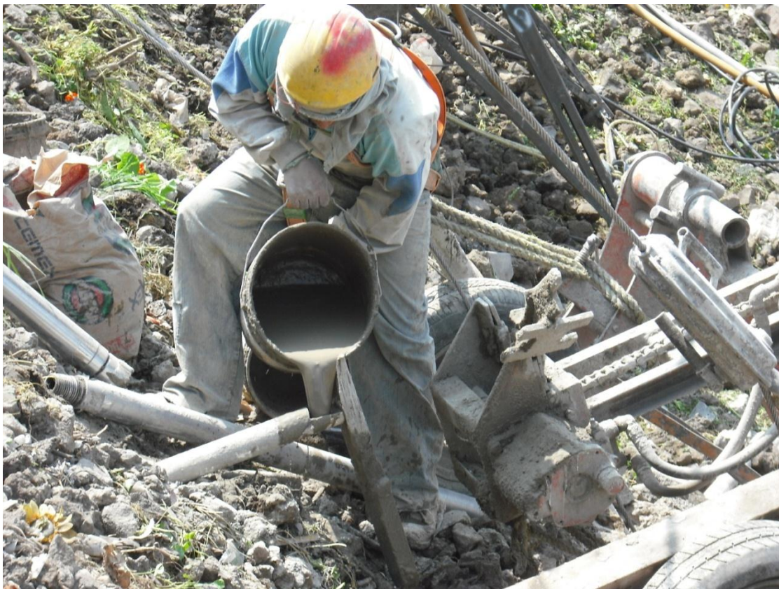
Figura 88. Mezcla cemento arena para ademar las paredes del barreno.
