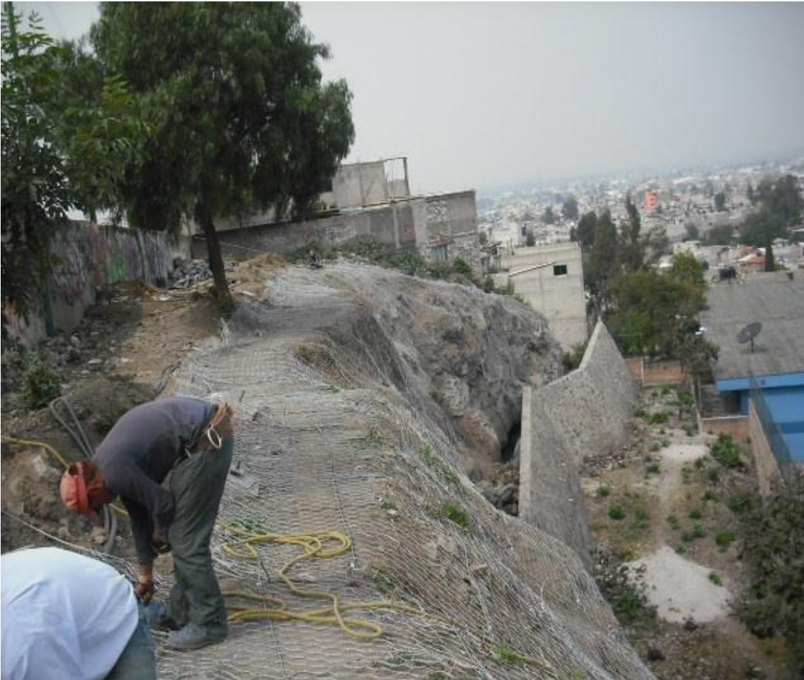
Figura 96. Detalle de doblé en malla triple torsión reforzada.
