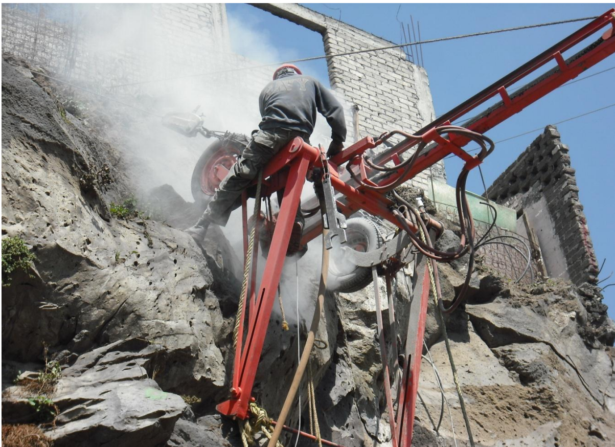
Figura 76. Perforación en el talud mediante el uso de equipo móvil Stenuick.
