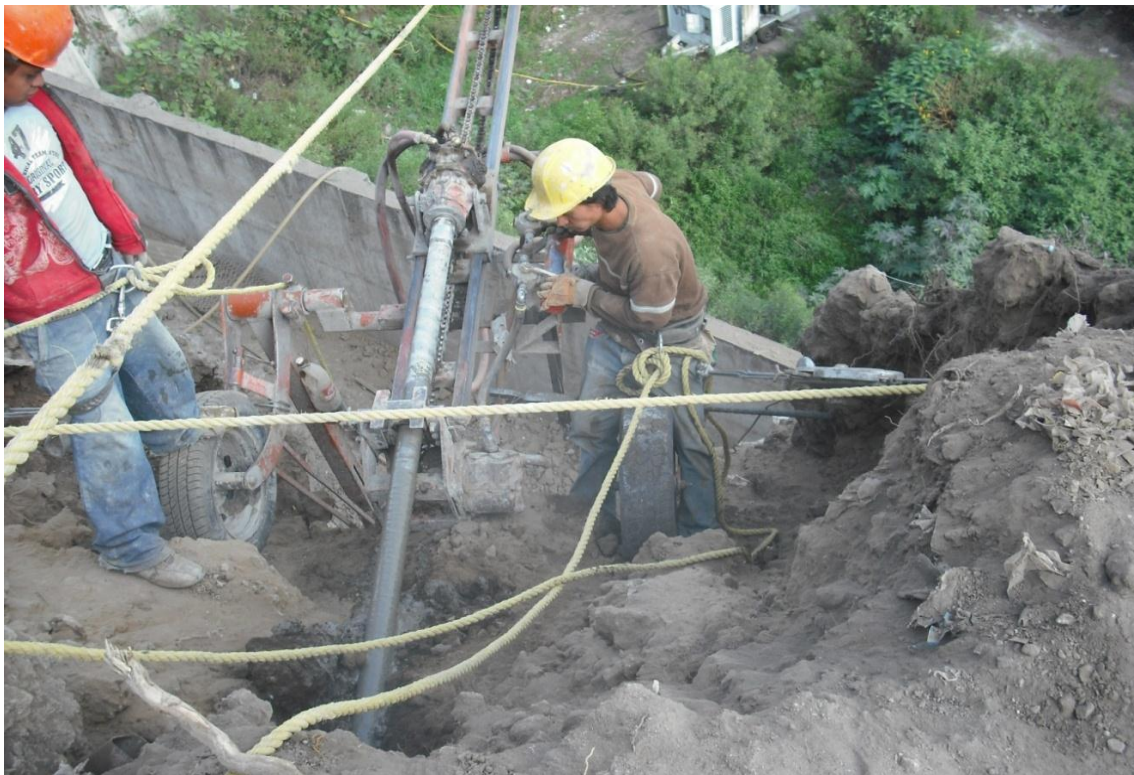
Figura 78. Perforación en basalto brechoide.
