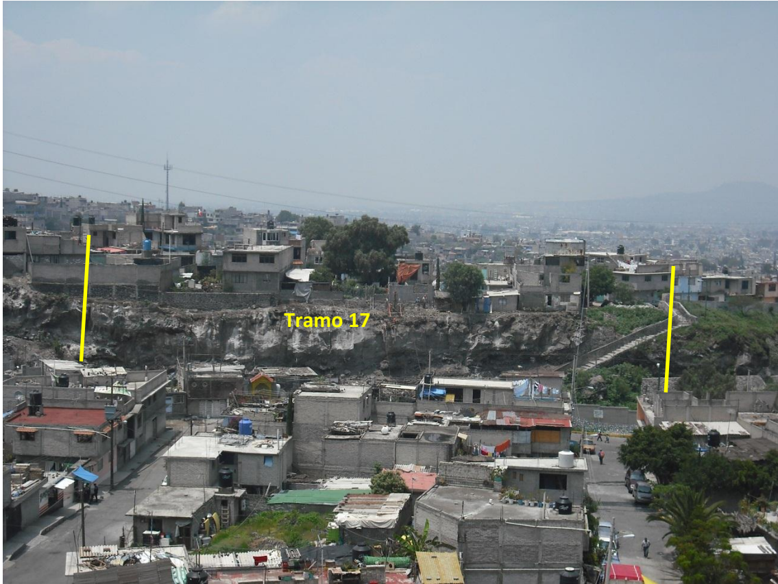
Figura 31. Vista frontal del tramo 17.
