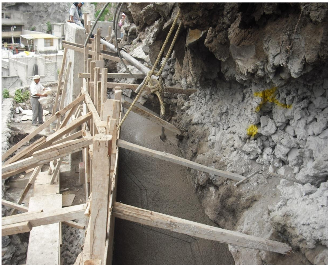
Figura 104. Colocación de relleno fluido.
