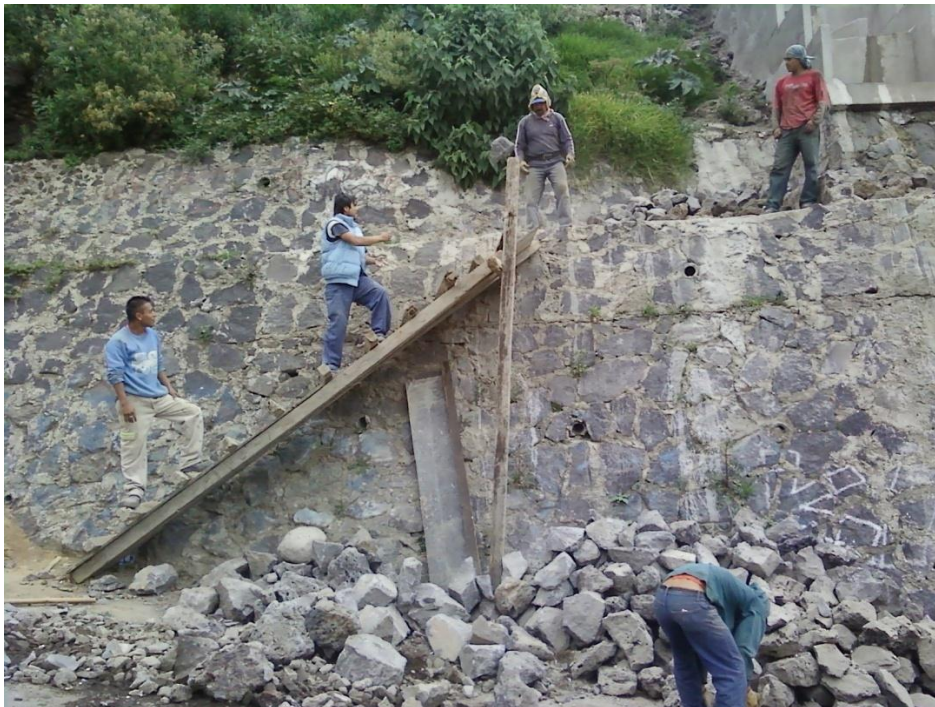
Figura 109. Acarreo de piedra para mampostería.
