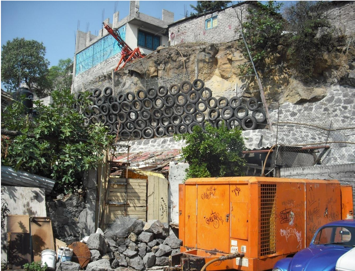
Figura 103. Colocación de barrera elástica para protección de viviendas en la base del talud.
