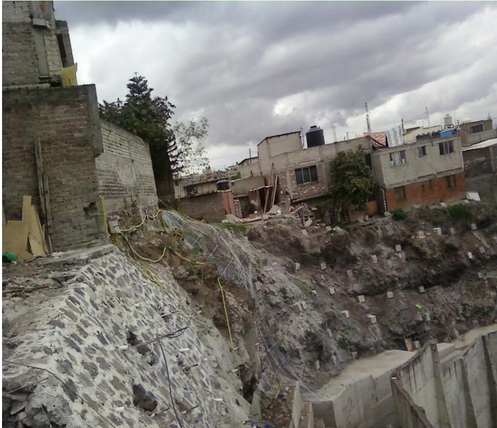
Figura 113. Lechada en talud para evitar el desprendimiento de material fino.
