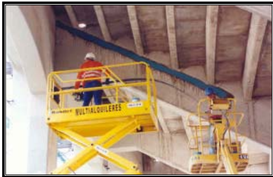
Figura 2.66 Colocación del laminado en vigas.
