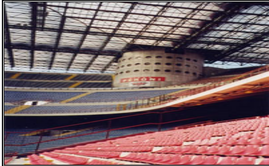
Figura 2.23 columnas de soporte de gradas y techo.
