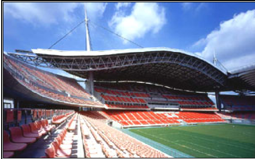
Figura 2.29 Pendones emergiendo a través de la estructura del techo.
