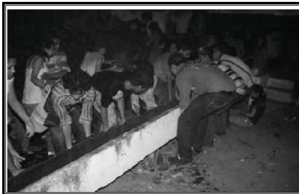
Figura 1.1.5. Desplome de una parte de la tribuna occidental del estadio de Neiva durante concierto musical
