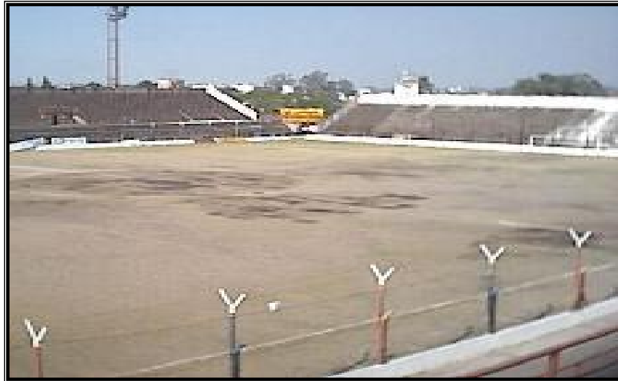
Figura 2.1. Estructura del estadio Huracán Corrientes – Argentina.
