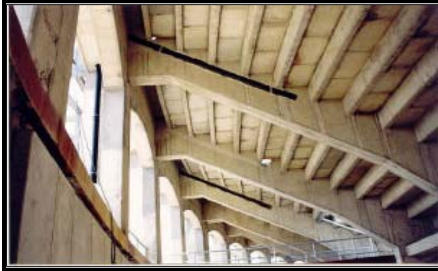
Figura 2.67 Estado final del refuerzo.
