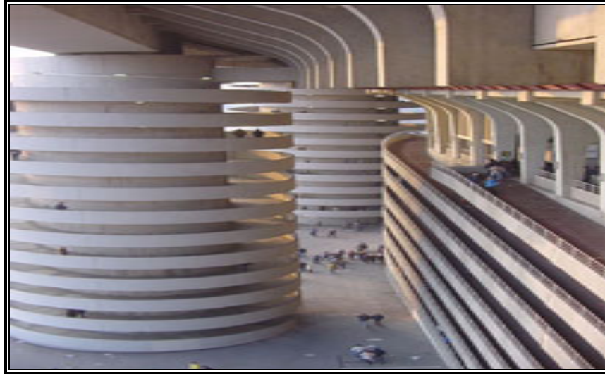
Figura 2.22 Torres cilíndricas de concreto armado.
