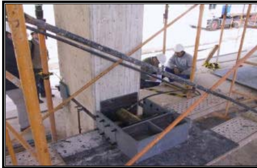
Figura 2.63 Laminado y chapa de acero.
