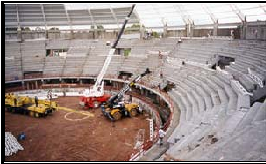
Figura 2.46 Construcción de Gradas Lienzo Charro Morelia, Michoacán.
