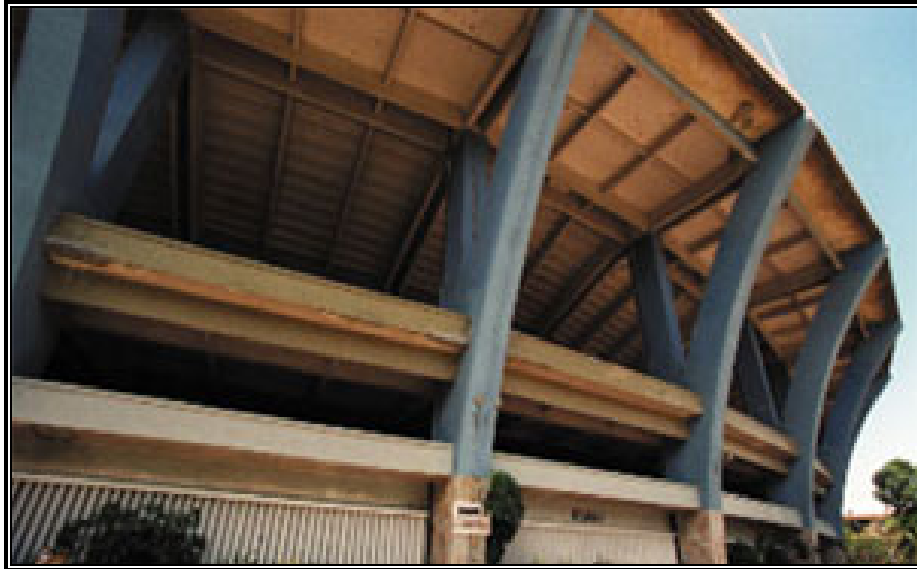
Figura 2.26 Pilares que adornan la fachada principal.
