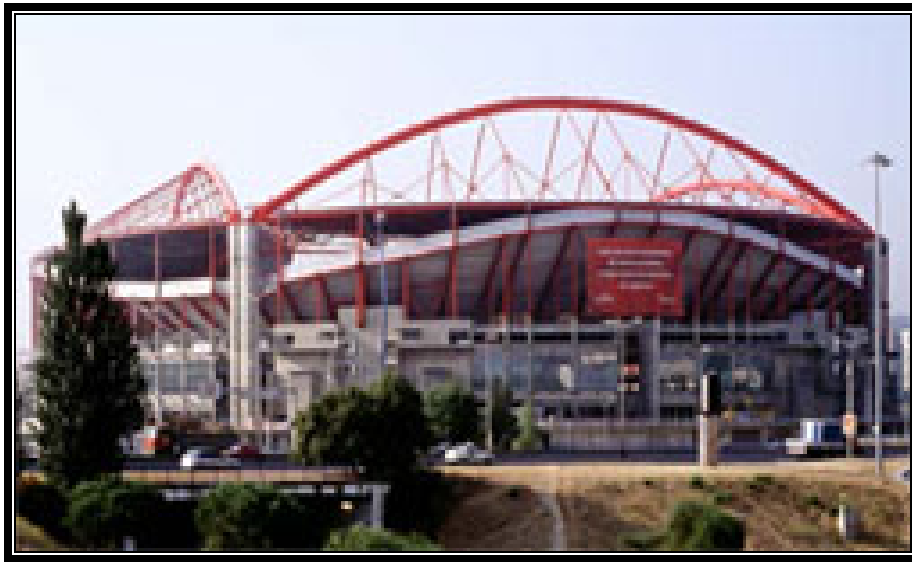
Figura 2.33 Arcos de acero sobre pilares angulares.
