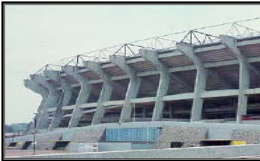
Figura 2.44 Columnas del Estadio Azteca.
