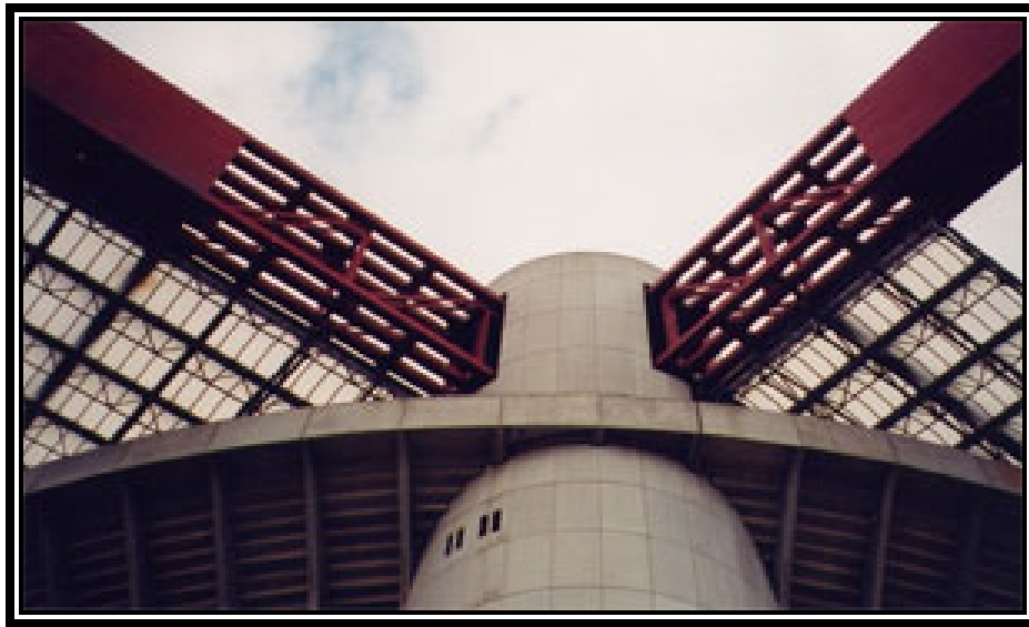
Figura 2.20 union de techo y gradas a las columnas portantes.
