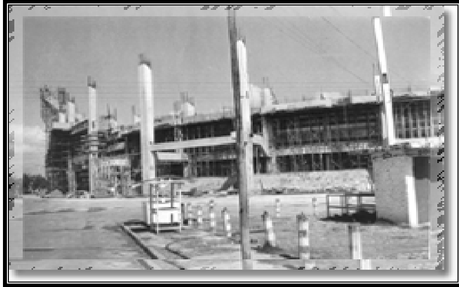
Figura 2.10 Construcción del estadio Jalisco, México.
