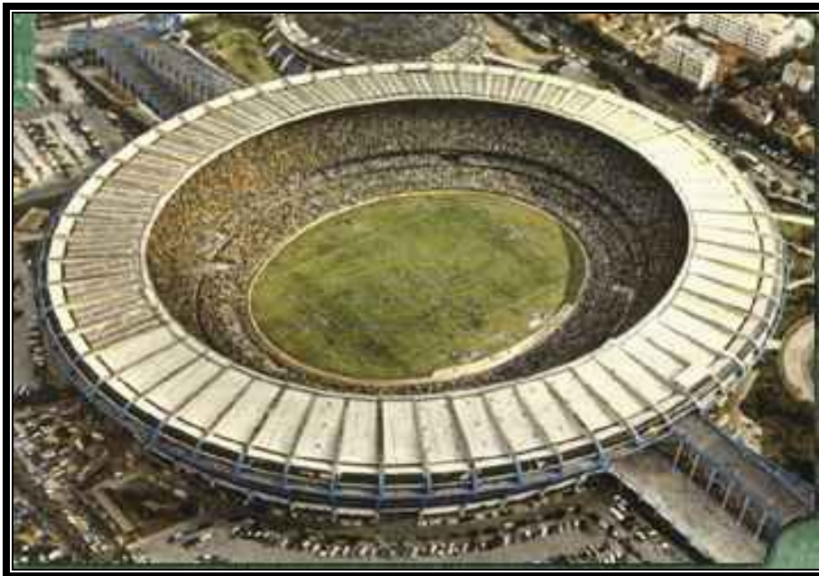
Figura. 1.1.1 Vista del estadio de Maracanã, Brasil.
