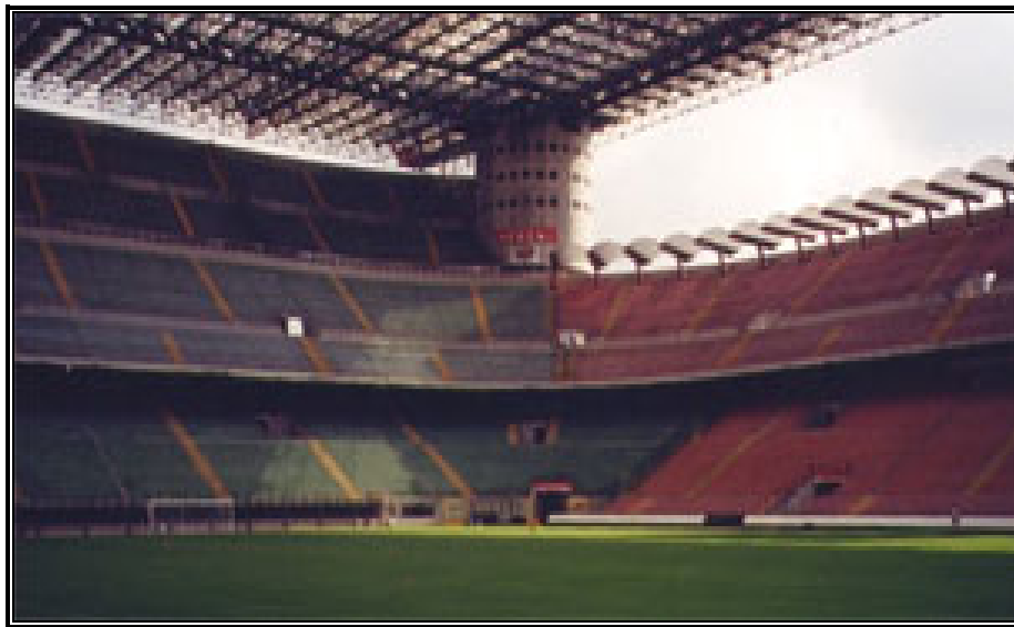
Figura 2.21 vista de las gradas superiores apoyadas de la columna de concreto.
