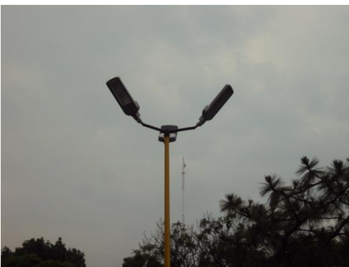
Fig. 110 Nuevas Luminarias en el Estacionamiento
