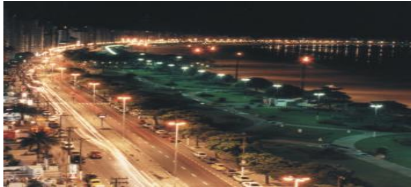
Figura 60. Iluminación con lámparas de vapor de sodio de alta presión.
