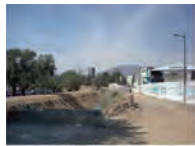
2. CANAL RÍO SAN JAVIER
