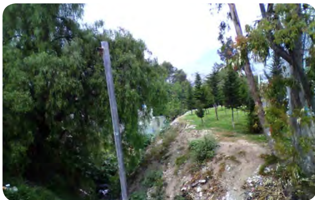
4.104 . Erosión en barrancos urbanos.
