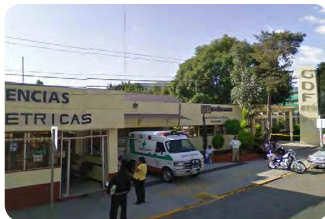
2.65 Equipamiento de salud, Hospital de Ginecobstetricia Maternal Infantil Cuauhtepec
