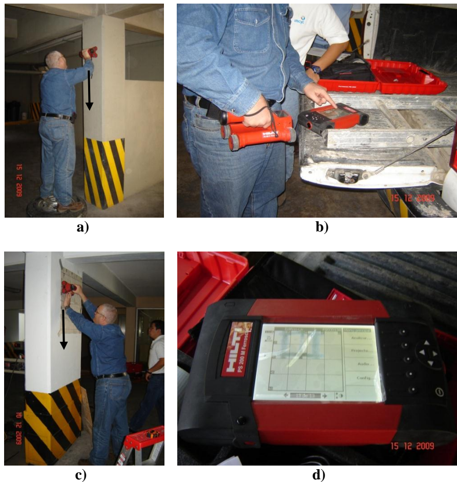
Figura 3.13 Escaneo en columna de concreto armado: a) medición lineal vertical, b) Transferencia de datos al monitor del escáner, c) medición superficial vertical o tipo Imagescan, d) análisis de la imagen.
