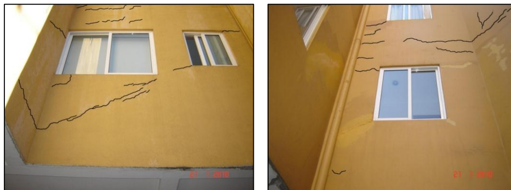
Figura 5.8 Grietas en muros
