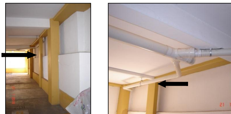
Figura 5.5 Columnas de apoyo existentes no identificadas en los planos estructurales
