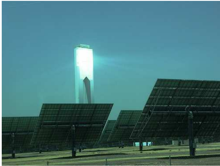
Figura F. Centrales de Torre.
