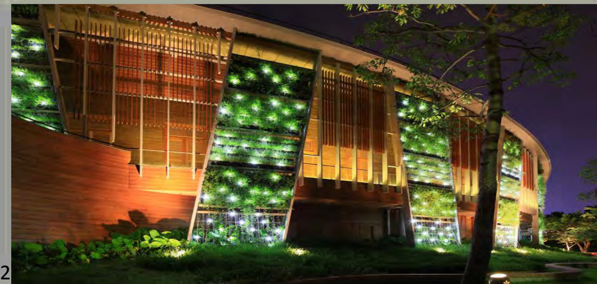
Vista de la fachada frontal de conjunto en donde se observa el uso de muros verdes, los cuales usaremos para aislar acústica y térmicamente el edificio
