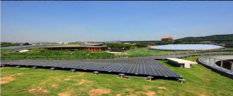
Paneles solares en el techo verde de pabellón
