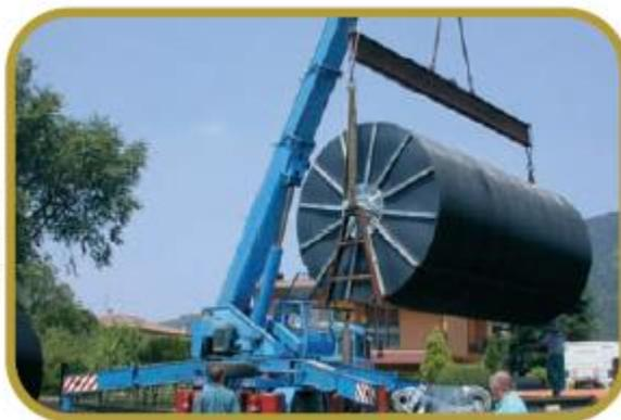
Ilustración 48. Contactor Biológico Rotativo
