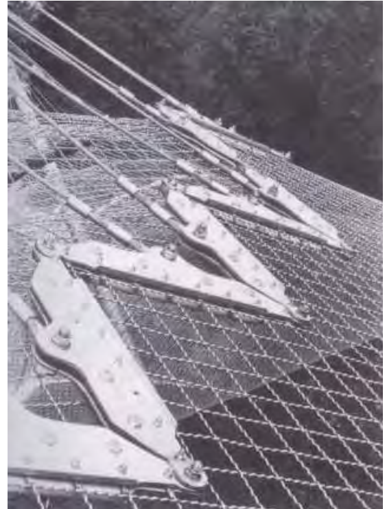
Imagen 6 Detalle de sistema pant6grafo
