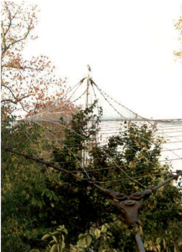
Imagen 16 Detalle de punta de anclaje.
