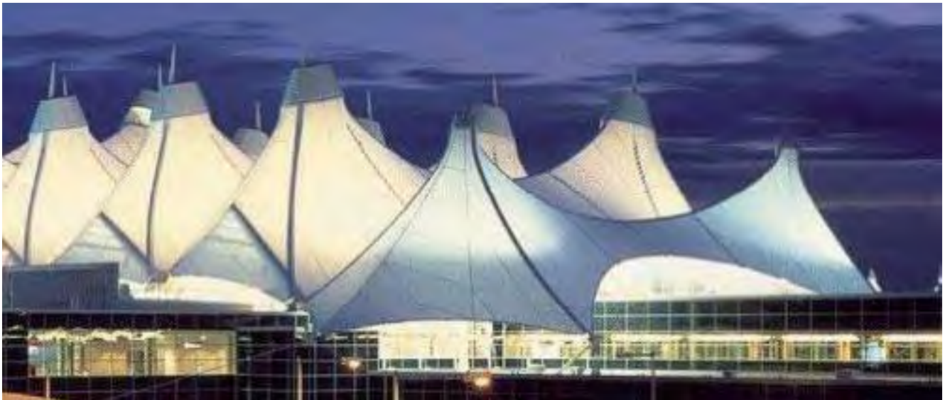
Imagen 21 Vista exterior de la cubierta.
