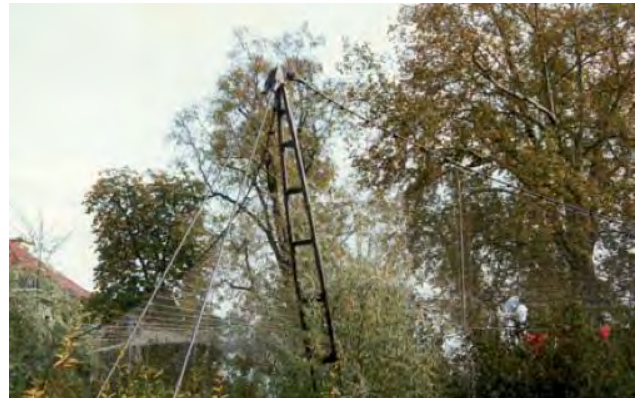
Imagen 13 Detalle de poste y cables.
