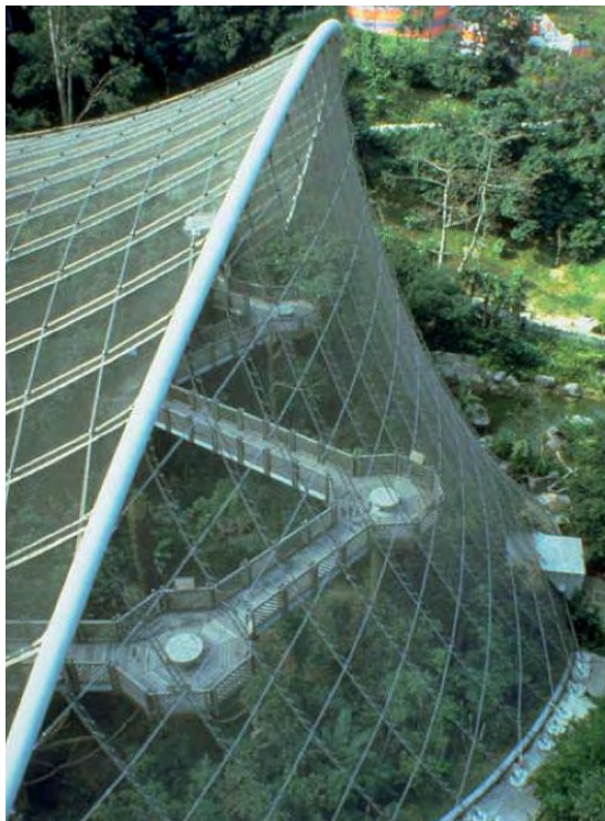
Imagen 19 Vista aérea de arco de acero.
