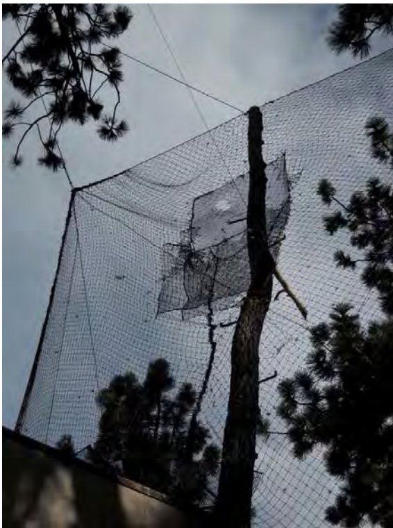
Imagen 5 Zona aviario actual: detalle de cables y parches en malla.
