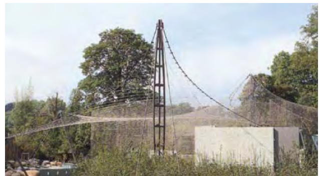
Imagen 14 Detalle de poste cable
