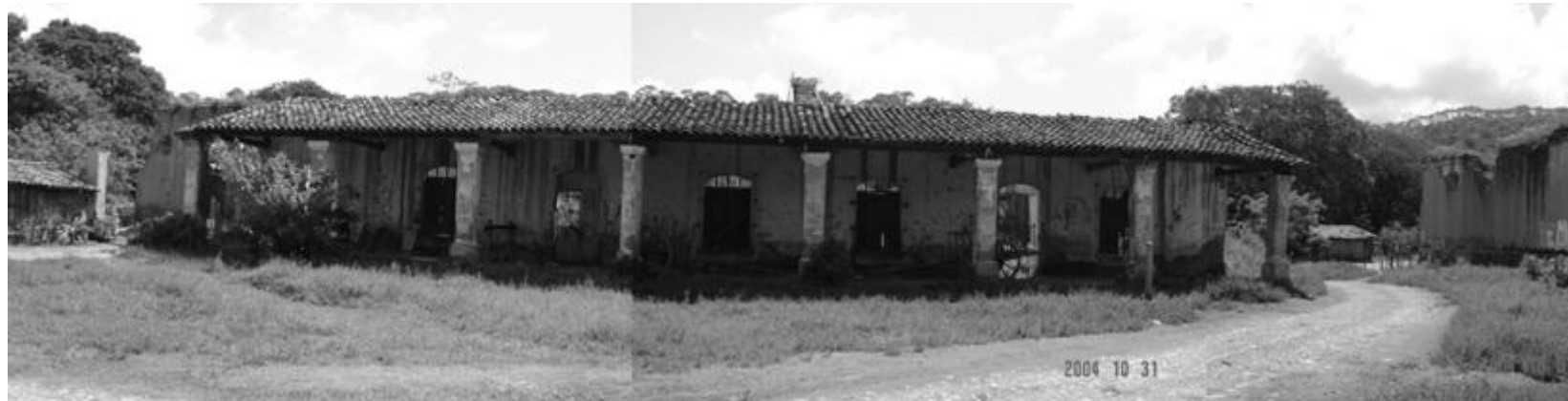
FACHADA PRINCIPAL "ADMINISTRACION" IMAGEN 102
