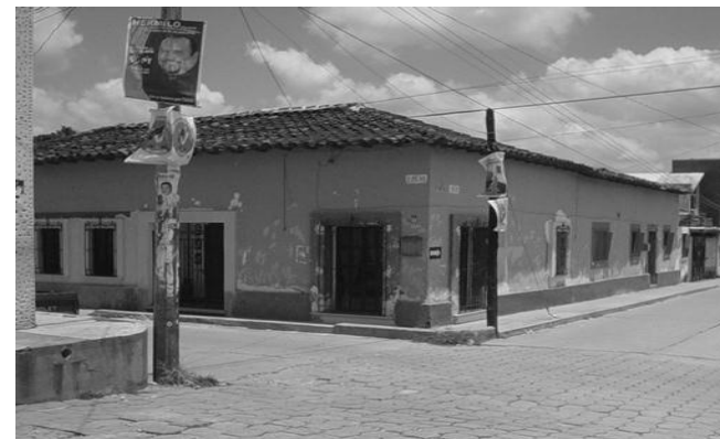
VIVIENDA TIPO DEL MUNICIPIO DE CINTALAPA DE ADOBE Y TEJA IMAGEN 93
