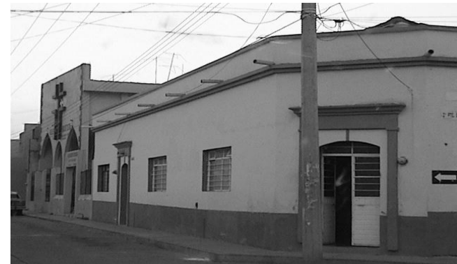
VIVIENDA TIPO DEL MUNICIPIO DE CINTALAPA DE CONCRETO ARMADO IMAGEN 92
