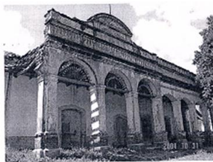
VISTA FACHADA NAVE INDUSTRIAL IMAGEN 98
