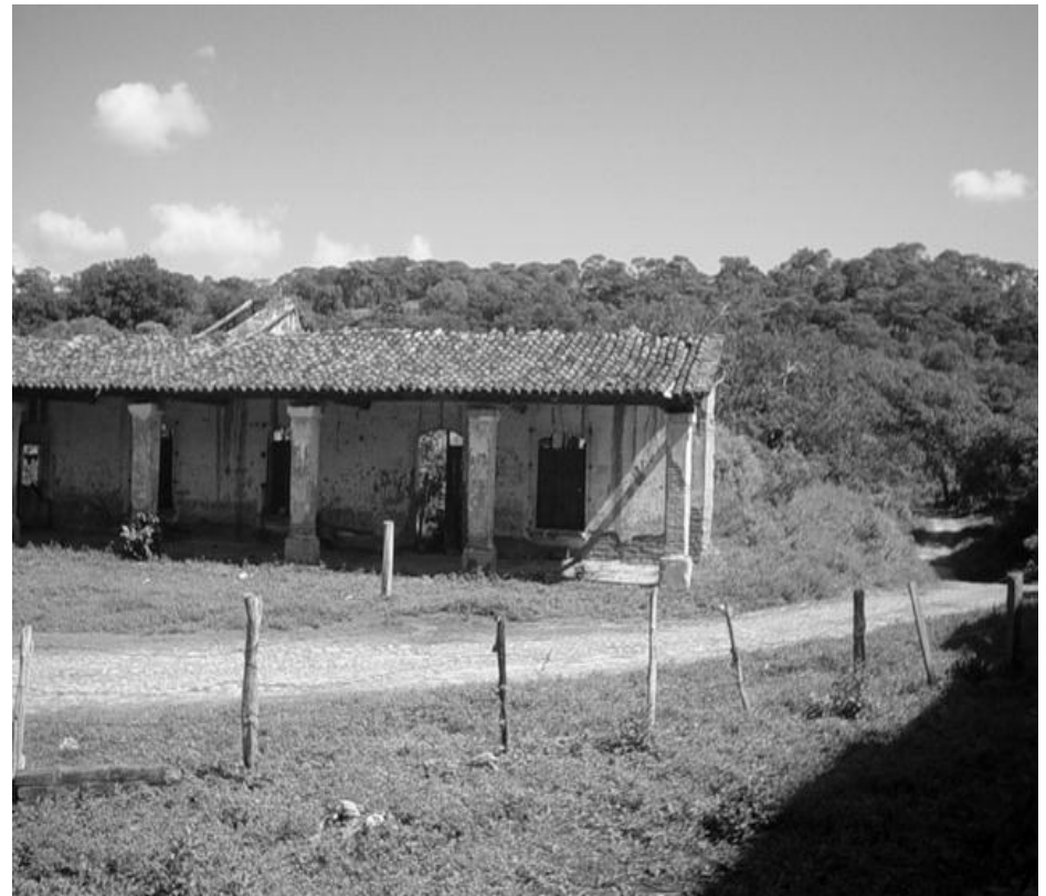
VISTA DE LA FACHADA LATERAL DE LA FINCA “LA PROVIDENCIA” IMAGEN 1
