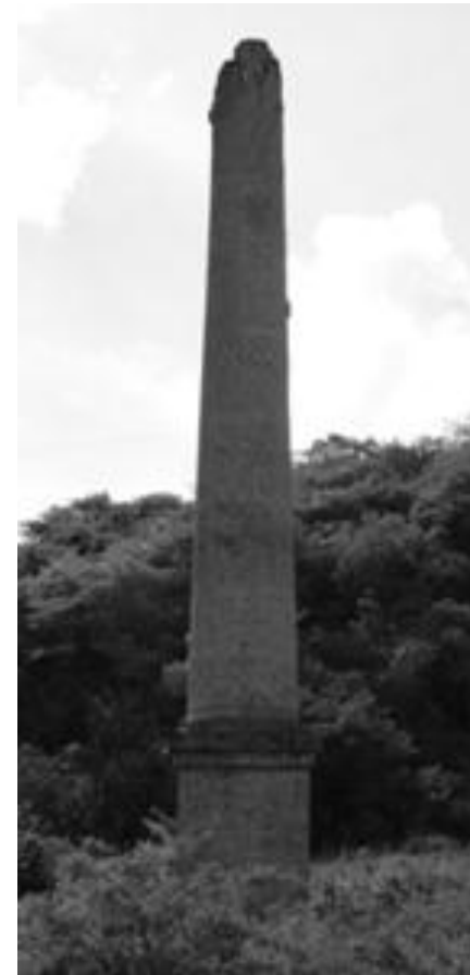
VISTA "CHIMENEA" IMAGEN 104
