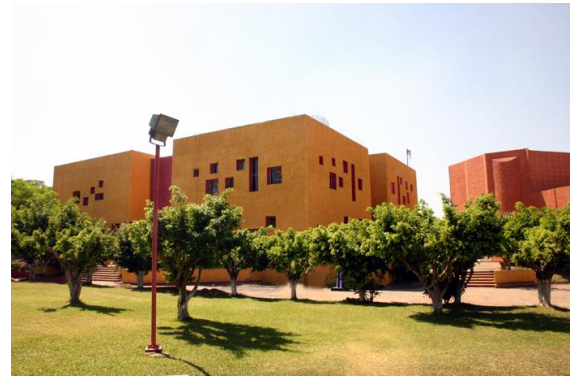
Foto. Vista general de la fachada
