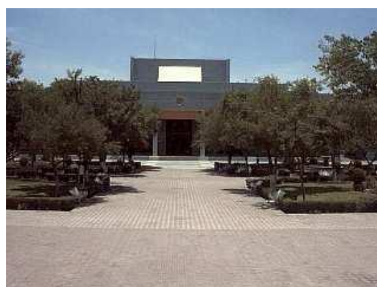
Fachada del Centro Cultural vista desde la Plaza
