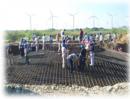
Figura III.9. Excavación para aerogenerador
