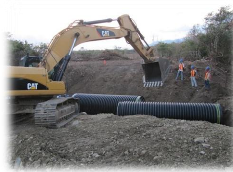
Figura III.15. Colocación de ductos de alta densidad
