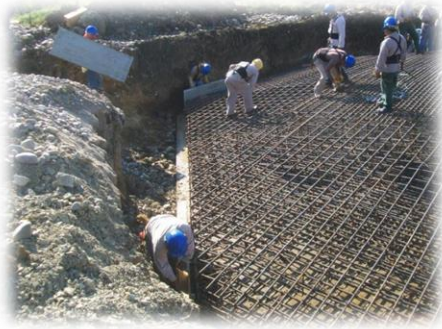
Figura III.8. Excavación para cimentación
