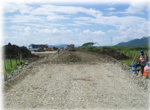
Figura III.16. Construcción de vialidad
