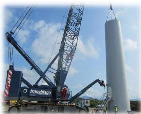
Figura III.18. Colocación de primera sección del aerogenerador
