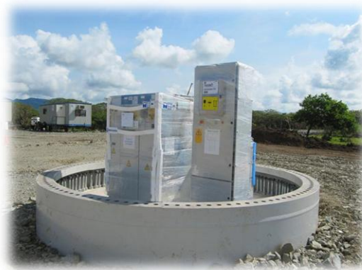
Figura III.17. Colocación de tablero de control
