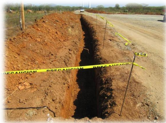
Figura III.26. Excavación de bus colector
