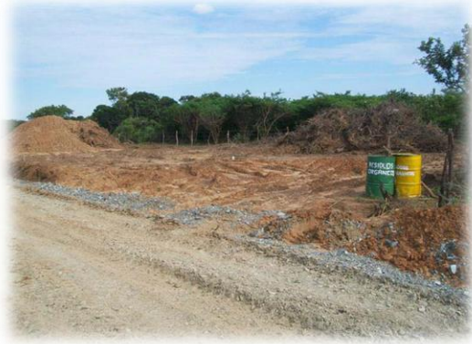
Figura III.5. Conformación de plataforma de montaje
