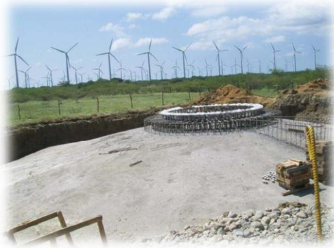
Figura III.14. Colocación de concreto en cimentación de aerogenerador
