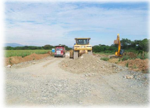
Figura III.6. Conformación de material de banco en camino
