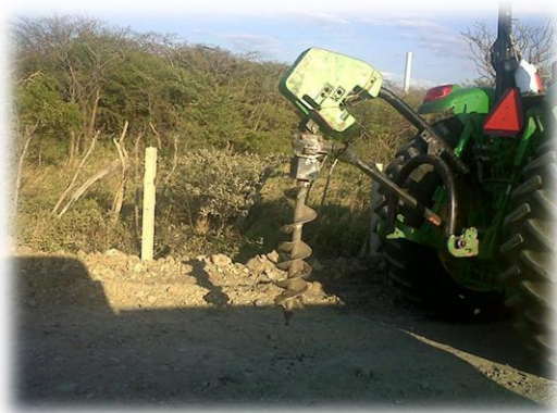
Figura III.24. Colocación de cerca perimetral en caminos
