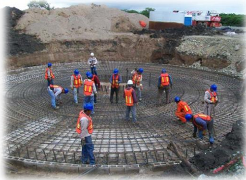
Figura III.12. Colocación y armado de acero de refuerzo para cimentación
