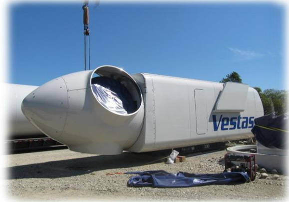
Figura III.21. Acoplamiento de buje en nacelle
