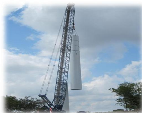
Figura III.19. Montaje segunda sección del aerogenerador
