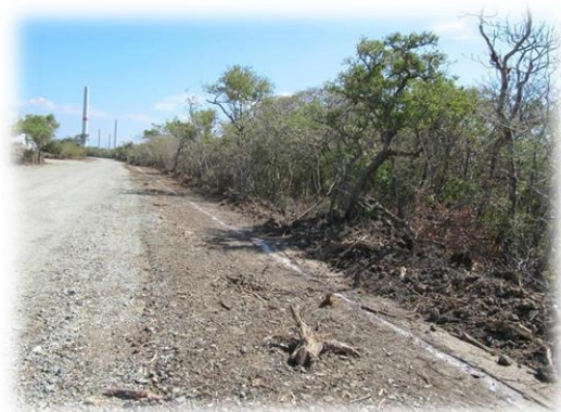
Figura III.25. Trazo para excavación de bus colector
