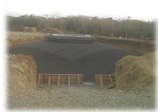
Figura III.13. Armado y cimbrado de zapata
