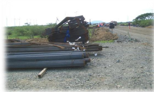
Figura III.7 Almacenamiento de acero de refuerzo
