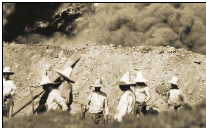
Figura II. 6. Pozo Juan Casiano No. 7. Control de los derrames e incendios. Los trabajadores construían una pared de tierra alrededor del pozo para apagar el incendio (Tomada de Brown, 1988).
