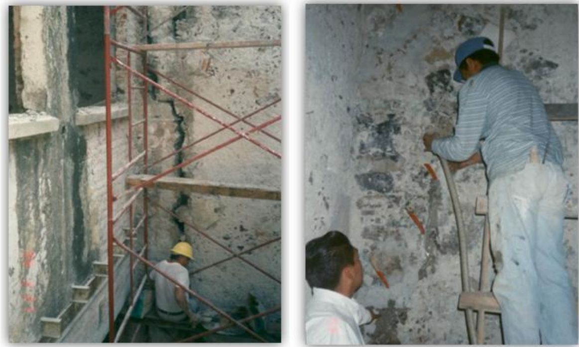
Figura 2.48. Reparación de la grietas con inyecciones de emulsión epóxica en muros de mampostería [2.16].
