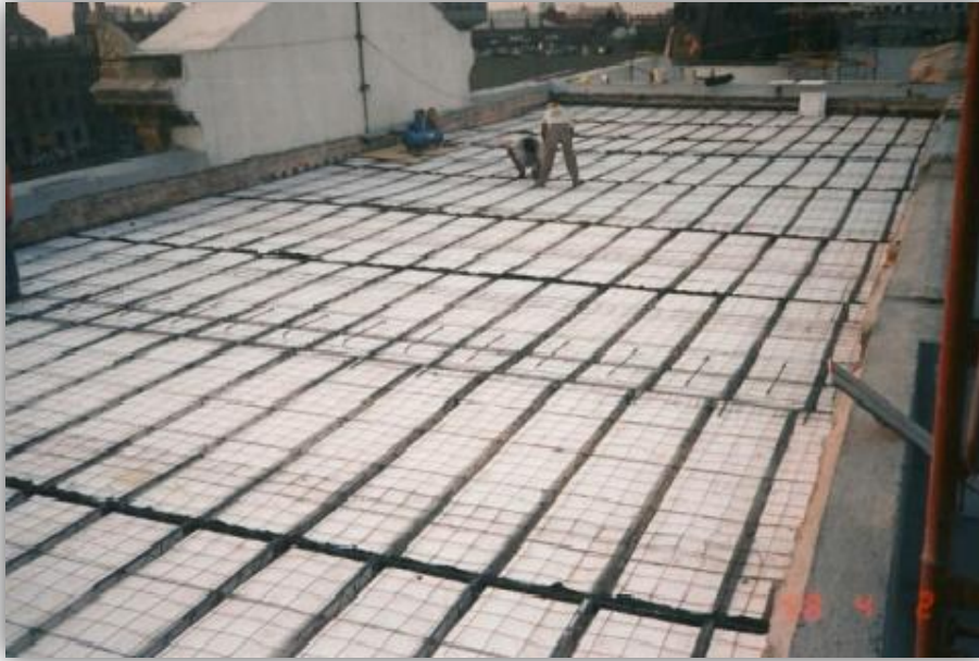
Figura 2.52. Sistema losacel utilizado en el paraninfo [2.16].
