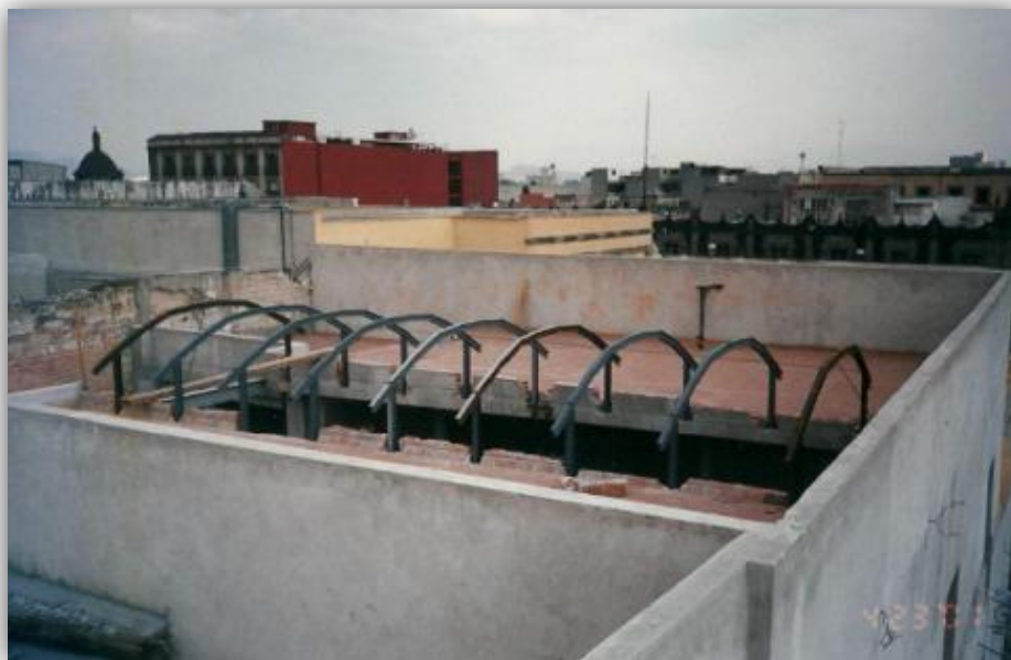
Figura 2.61. Colocación de estructura metálica en patio E antes de la colocación de su cubierta tipo cristal [2.16].
