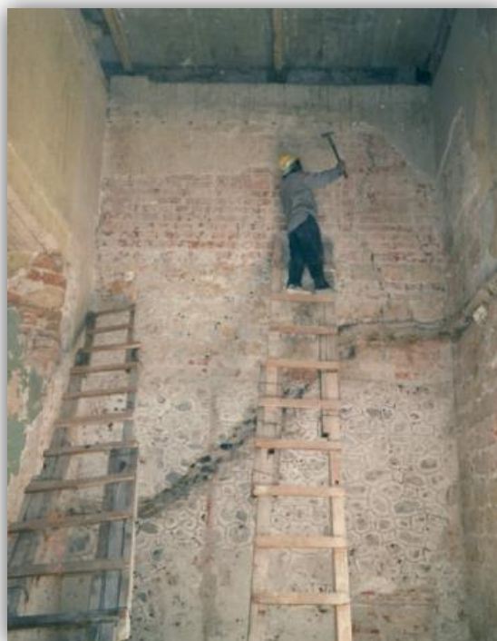
Figura 2.55. Eliminación de aplanados en local 59, se observa que el muro está constituido de piedra, tezontle, tepetate y tabique, además de los restos de una escalera [2.16].
