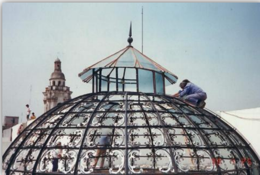
Figura 2.54. Colocación del tapiz tipo cristal en cúpula del vestíbulo principal [2.16].
