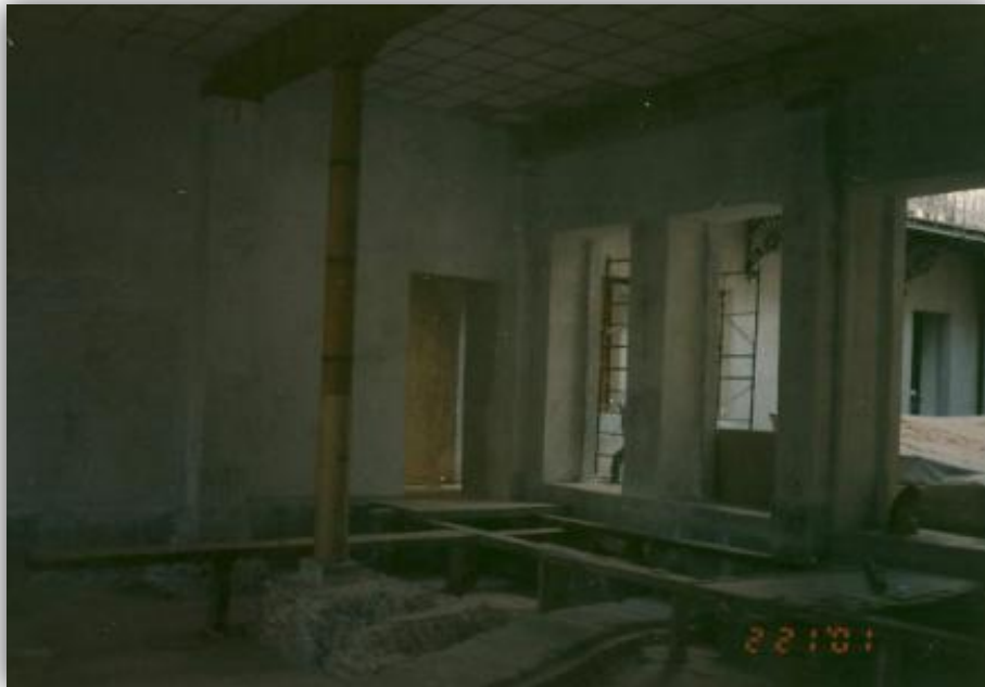
Figura 2.57. Local 16 antes de colocarse la ventana arqueológica, se observan algunos vestigios arqueológicos del convento de Santa Teresa [2.16].
