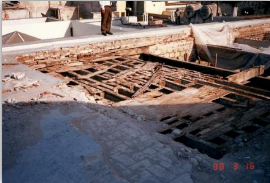
Figura 2.50. Demolición del sistema de cubierta del paraninfo [2.16].
