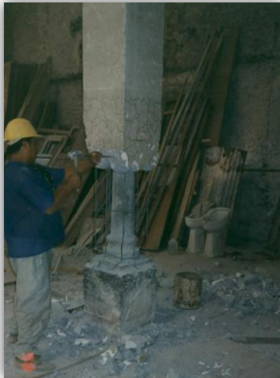
Figura 2.62. Retiro de concreto en columna metálica [2.16].
