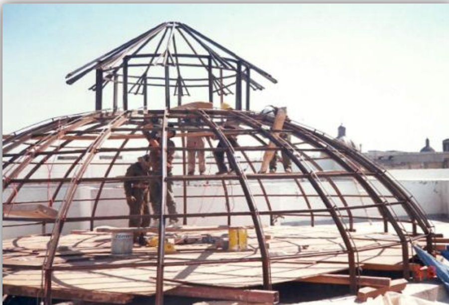
Figura 2.53. Restauración de la cúpula acristalada del vestíbulo principal [2.16].
