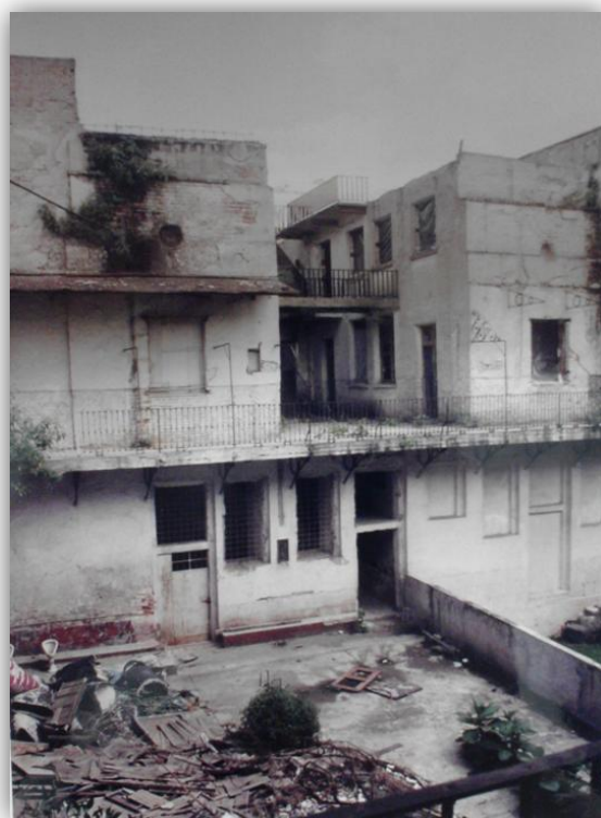
Figura 2.29. Vista del Patio D y del edificio anexo, antes de las excavaciones [2.16].
