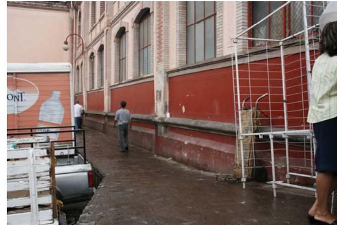
Fig. 18. Vista de la fachada frontal poniente. Véase los deterioros por humedad en las basas de las columnatas.
