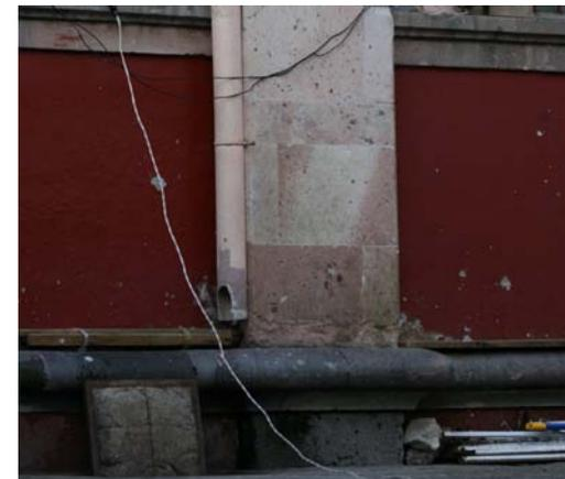
Fig. 20. Detalle de una basa de la fachada frontal oriente, véase el deterioro por humedad que están generando las bajadas de agua pluvial en mal estado.
