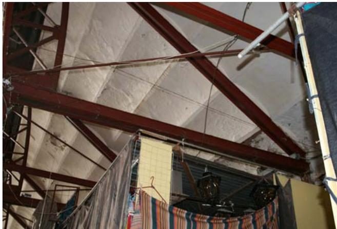
Fig. 16. Vista de crujía posterior, misma que contiene el coceo de los empuje de las fuerzas laterales. Fabricada con bóvedas escarzasas.
