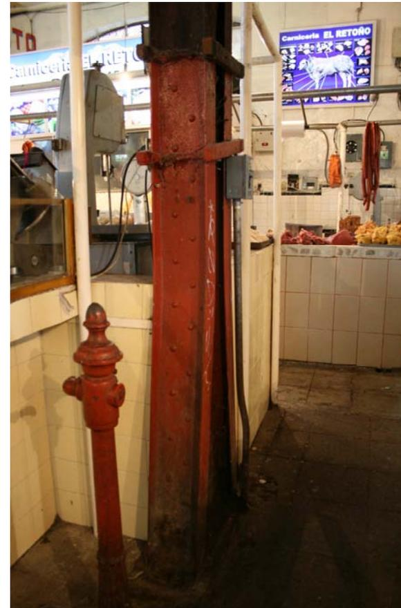
Fig. 15. Detalle de una de las columnas que reciben todas las cargas transmitidas por los arcos. Formadas por tres vigas I formando una H y remachadas entre sí.
