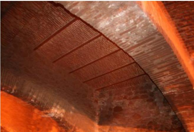
Fig. 3. Vista de la cimentación mixta, en este caso: bóvedas de cañón corrido descargando sobre los arcos de medio punto que forma el túnel.
