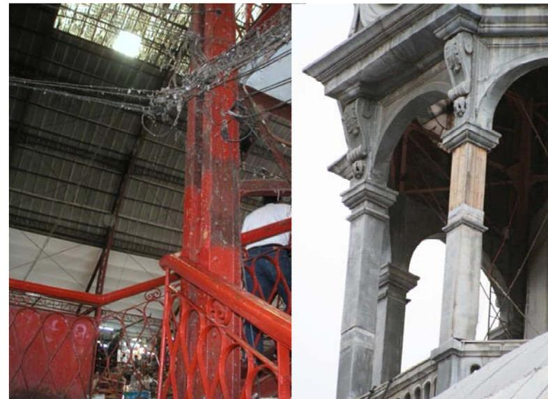
Izquierda: vista de escalera, nótese los cables de la instalación eléctrica en el paso de los usuarios.
