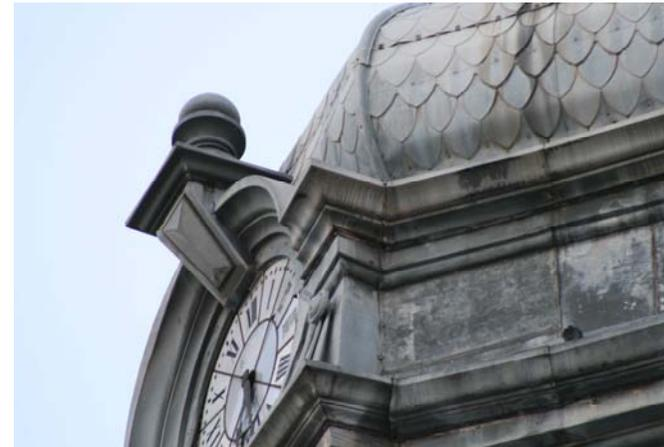
Fig. 8. Véase la unión de las laminillas de zinc, y su deterioro por oxidación.
