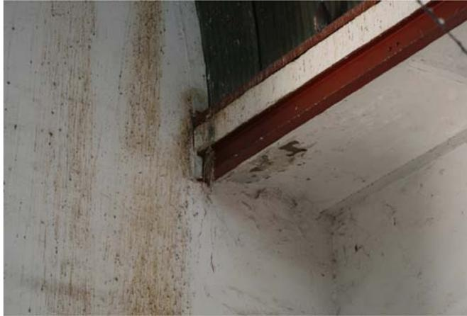
Fig. 23. Vista de los aplanados interiores del edificio, véase como la suciedad de las palomas han dañado a la par de la humedad han provocado el deterioro de los mismo.
