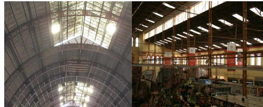
Izquierda: Detalle de la cubierta del mercado Hidalgo, se observan los lucernarios en la cumbrera de la estructura metálica, y los espacios de ventilación del mercado, así como el uso de lámina translúcidas. En el proyecto original estas áreas estaban cubiertas por vidrio plano.
