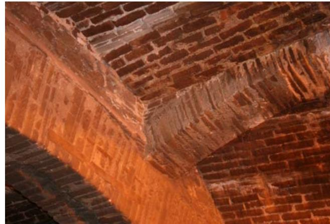
Fig. 4. Vista de los arcos secundarios descargando sobre los arcos principales.
