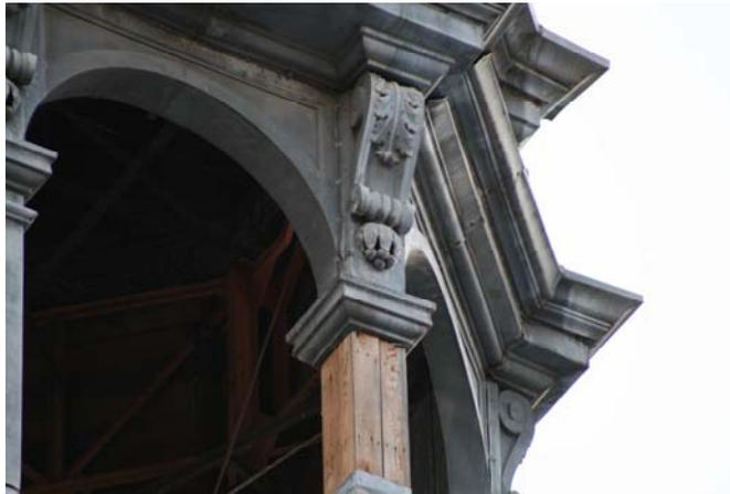
Fig. 7. Vista de la torre de reloj, obsérvese que el armazón es de madera y está recubierto por laminillas de zinc
