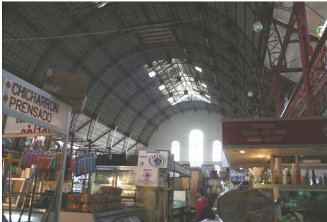
Fig. 13. Vista del interior del mercado, mostrando las armaduras de hierro en forma de arco de medio punto
