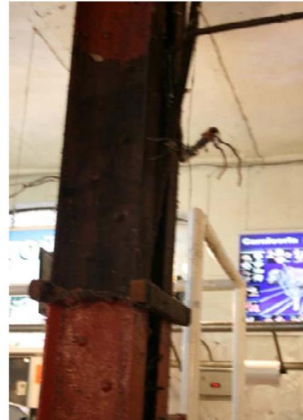
Arriba: Detalle de una de las columnas que conforman la estructura principal del mercado. Nótese la corrosión en una sección.
