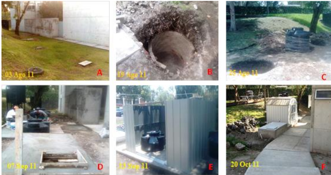
Figura III-25. Fotografías de la etapa de construcción del proyecto. (A) Terreno antes de la construcción del proyecto; (B) excavación para el cárcamo de bombeo; (C) instalación del biodigestor y excavación del sedimentador secundario; (D) cisterna y plancha de concreto de la caseta; (E) armado de la caseta y, (F) estado actual del proyecto.
