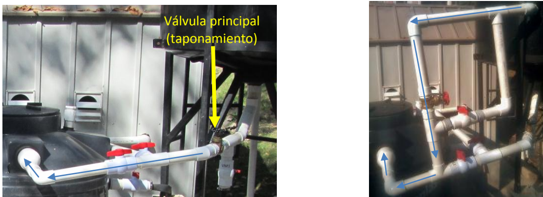
Figura IV-5. Ajuste en la alimentación del sedimentador primario: Izq.- Original. Der.- Ajustado. Las flechas indican el flujo hidráulico
