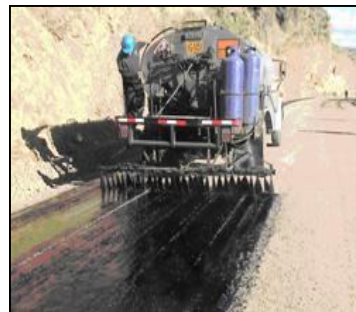
Fig. 10 Proceso constructivo de la imprimación reforzada
