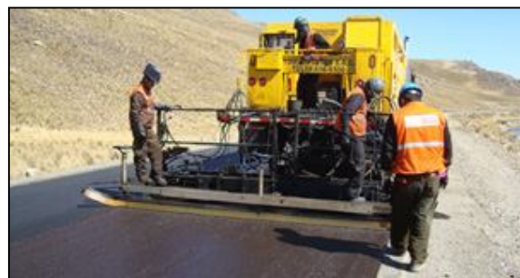
Fig. 16 Estabilización con emulsión asfáltica
