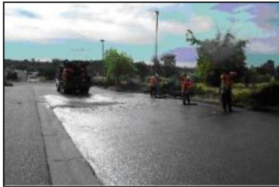
Fig.14 Ejecución del Slurry Seal
