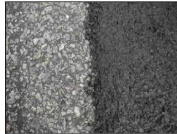
Fig. 15 Acabado final del Slurry Seal
