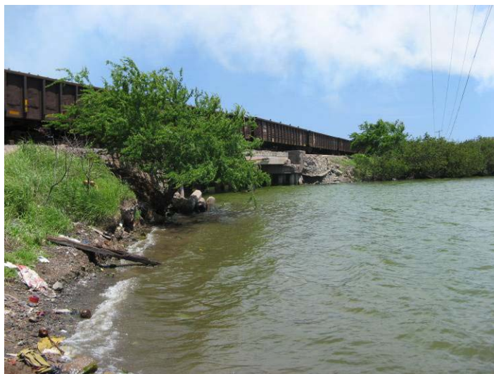
Figura II-15 Alcantarilla del ferrocarril, conexión entre el vaso I y vaso II
