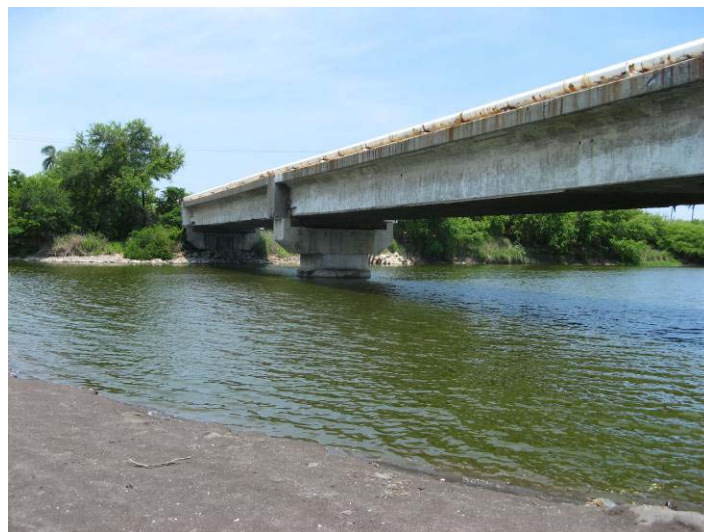
Figura II-13 Puente del ferrocarril
