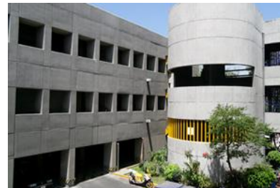
Edificio de aulas
