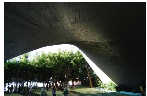
Foto desde dentro de la cubierta.
