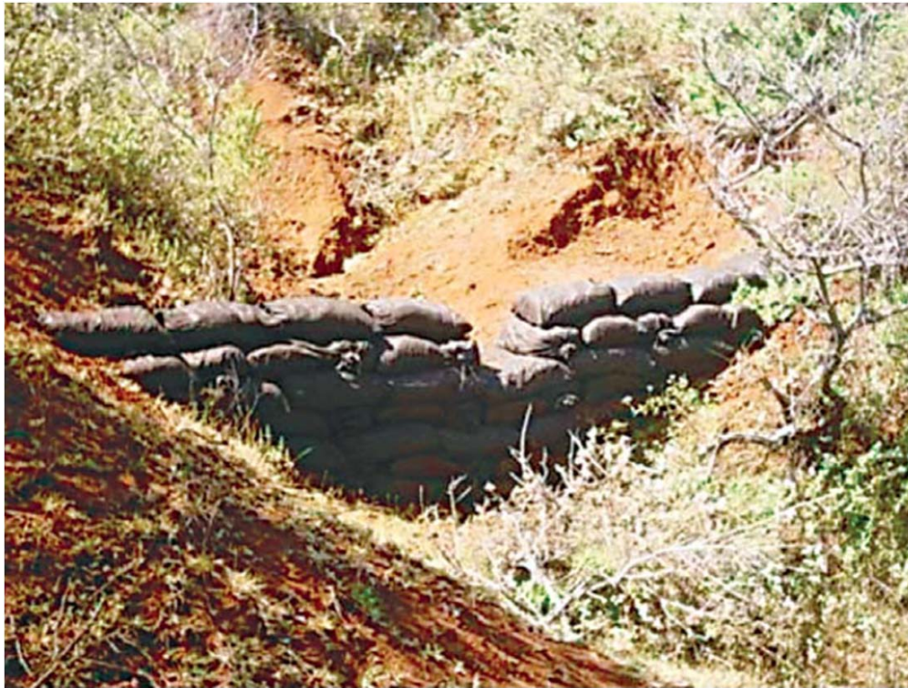
Figura 7.50. Presas de geocostales. (CONAFOR, 2007)
