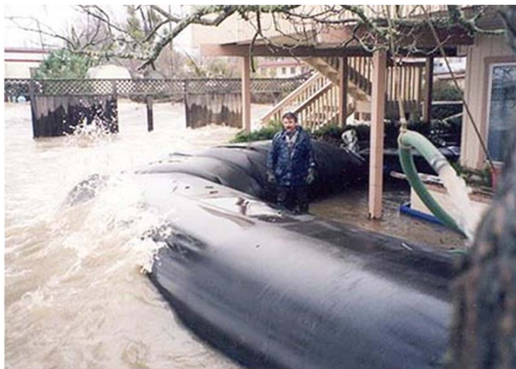
Figura 8.18 Geotubos para el control de inundaciones.
