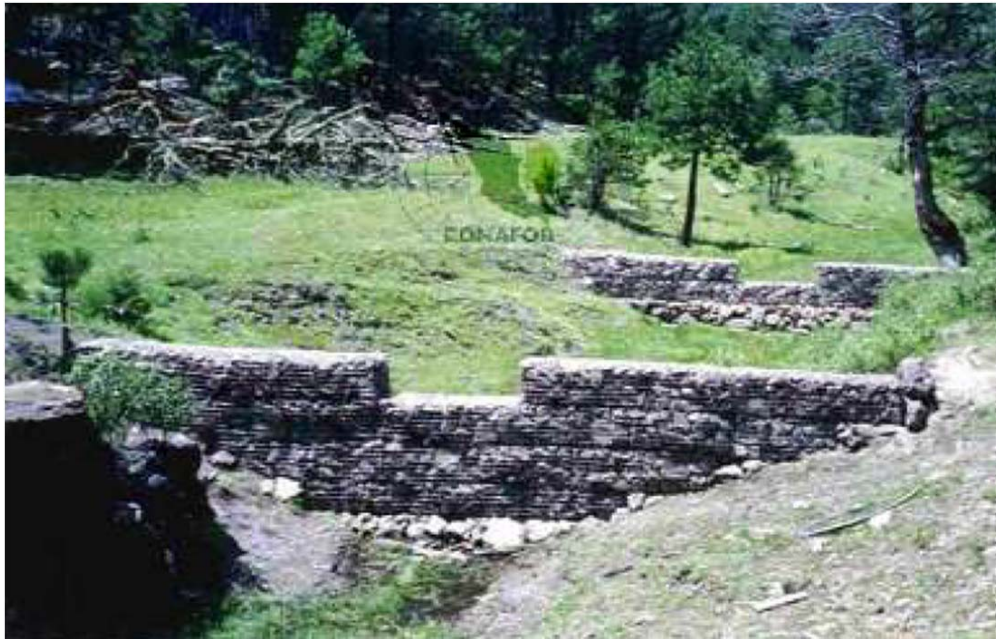
Figura 7.45. Presas de malla electro-soldada o ciclónica. (CONAFOR, 2004)
