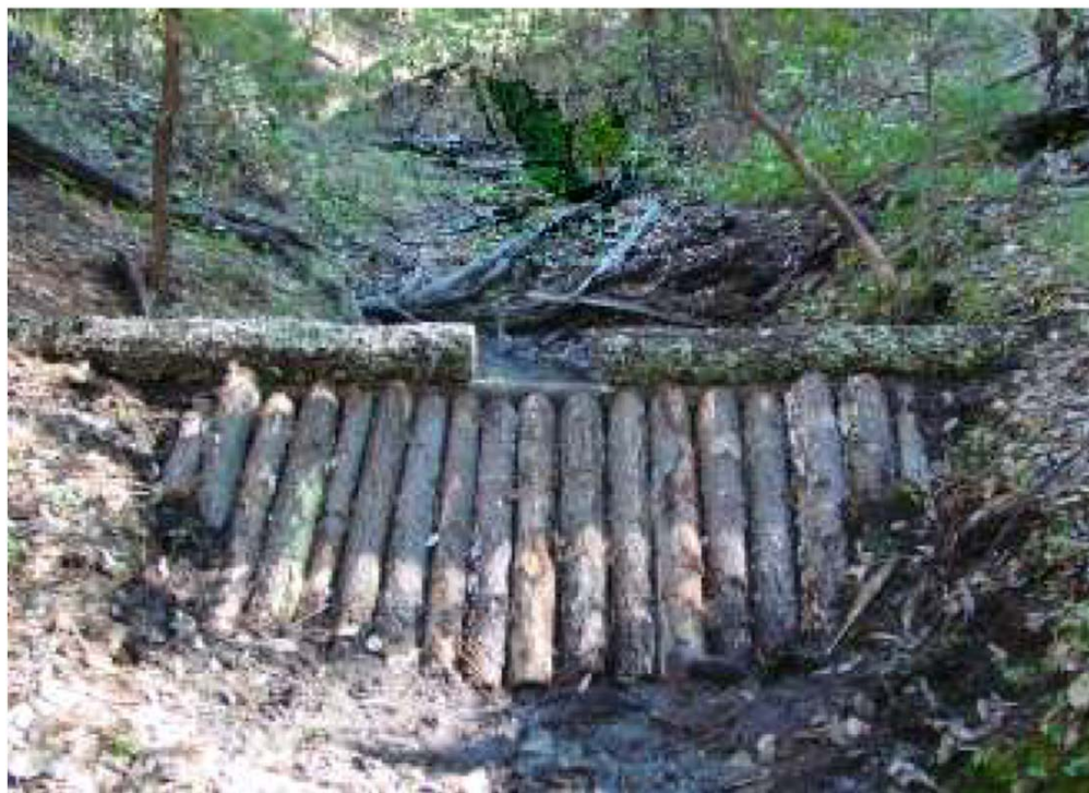
Figura 7.46 Presa de morillo. (CONAFOR, 2004)
