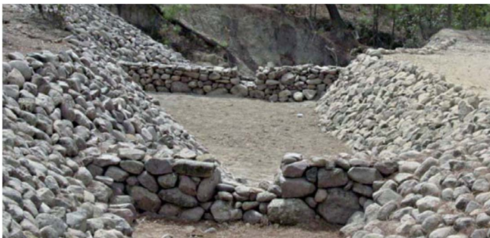
Figura 7.52. Estabilización de talud con piedra. (CONAFOR, 2007)
