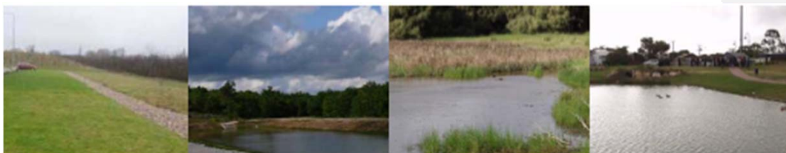
Figura 7.9. Franjas filtrantes, depósitos de detención, estanques de retención y humedales artificiales. (Prieto, 2012)
