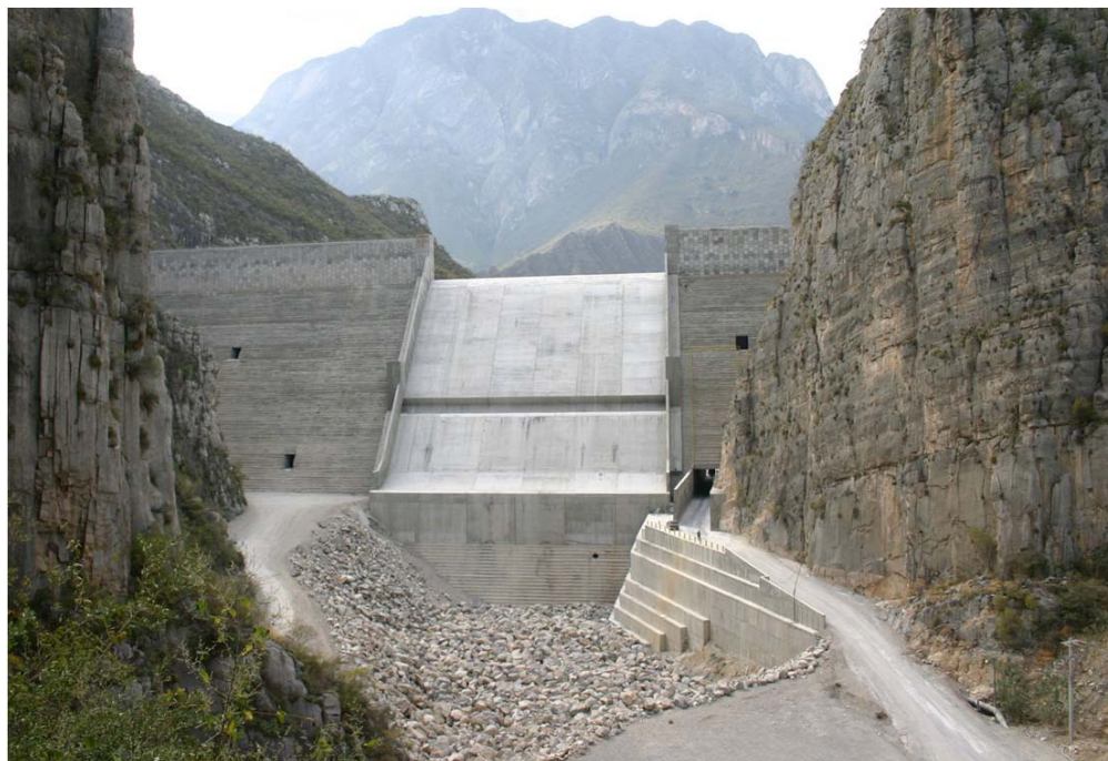
Figura 7.38. Presa rompe-picos del río Santa Catarina, Monterrey
