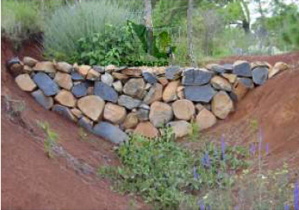
Figura 7.48. Presas de piedra acomodada. (CONAFOR, 2004)
