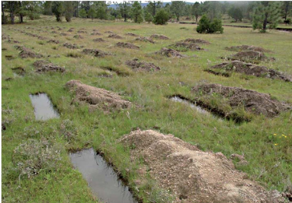
Figura 7.57. Zanjas trinchera. (CONAFOR, 2007)
