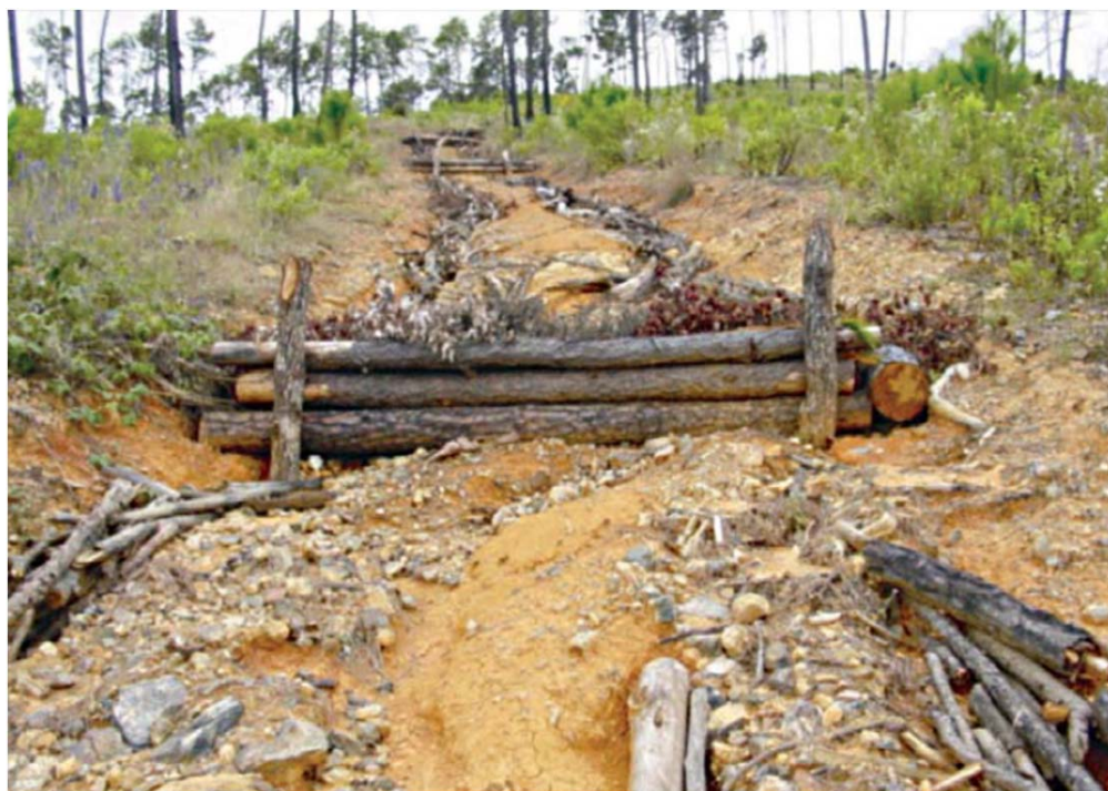
Figura 7.53. Obras de protección y conservación de caminos forestales. (CONAFOR,2007)
