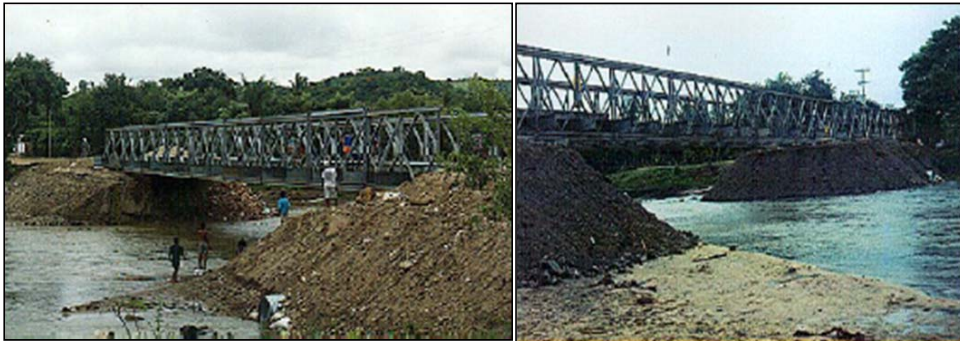
Figura 7.68. Puentes tipo Mabey. (SCT,2011)
