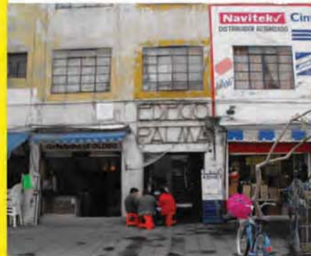
Arroba al edificio y comercios de la planta 1
