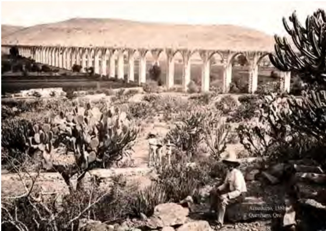
Figura 2.8. Acueducto de la Ciudad de Santiago de Querétaro en 1886 (Litografía de campo, 2009).
