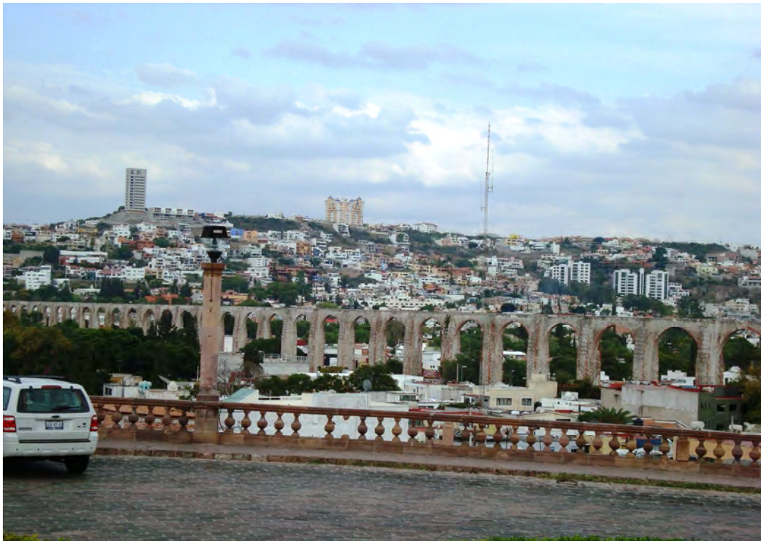
Figura 2.9. Acueducto de la ciudad en 2010 (Juárez H., noviembre 2010).
