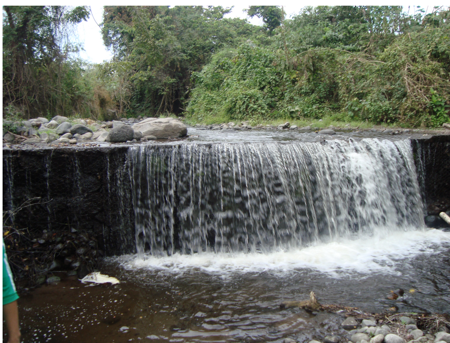
Imagen 12. Presas de gavión en el río construidas por el fraccionamiento Las Parotas Fotografía: A. Martínez (2012).
