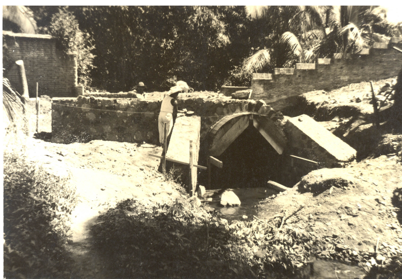
Imagen 10. Construcción de drenaje para descarga de aguas residuales al río Colima (AHMC, fototeca, AH-145).
